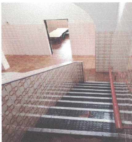
FIGURA 4 – ESCADAS PARA REFEITÓRIO
