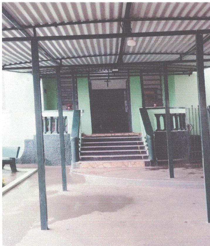
FIGURA 6 – ESCADA DA ENTRADA DA CRECHE
