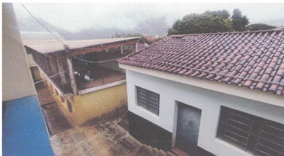
FIGURA 13 – CORREDOR EXTERNO DA CRECHE
