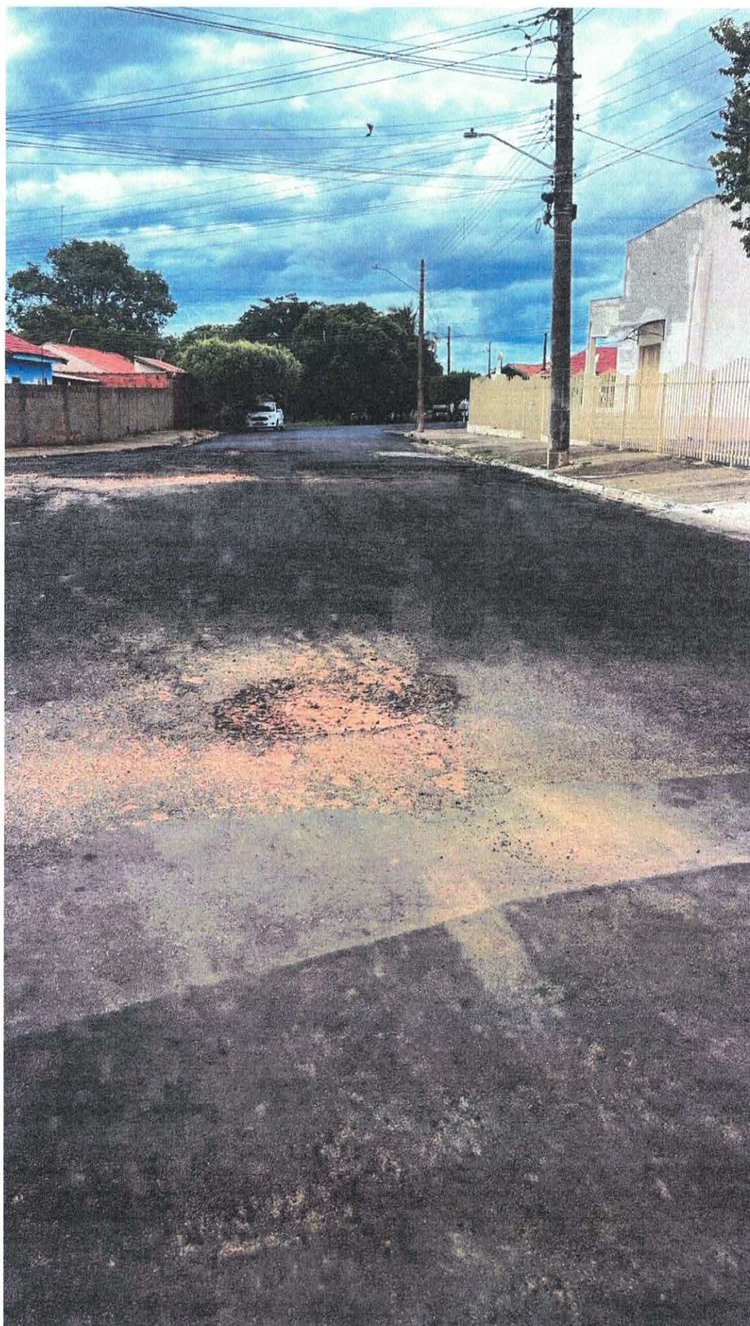
Anexo: Imagens do local (Rua Antônio Gonçalves Soares).
