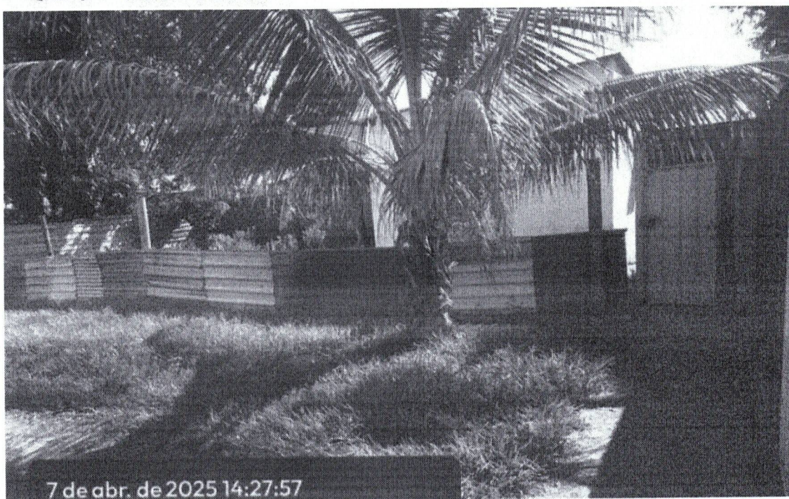
Figura 4 imagem do imóvel avaliando
