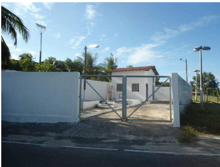
Figura 7.52 – Entrada da estação elevatória EEE-03 (Rua José Bento – Bairro Guaribas) do sistema de esgotamento sanitário do Eusébio/CE.
