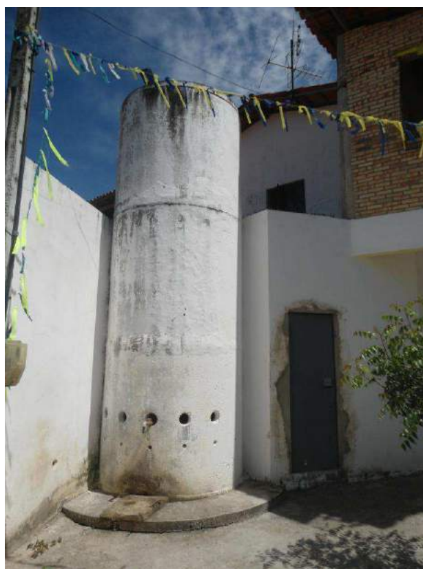
Figura 7.36 – Vista do chafariz no bairro Olho D'Água.
