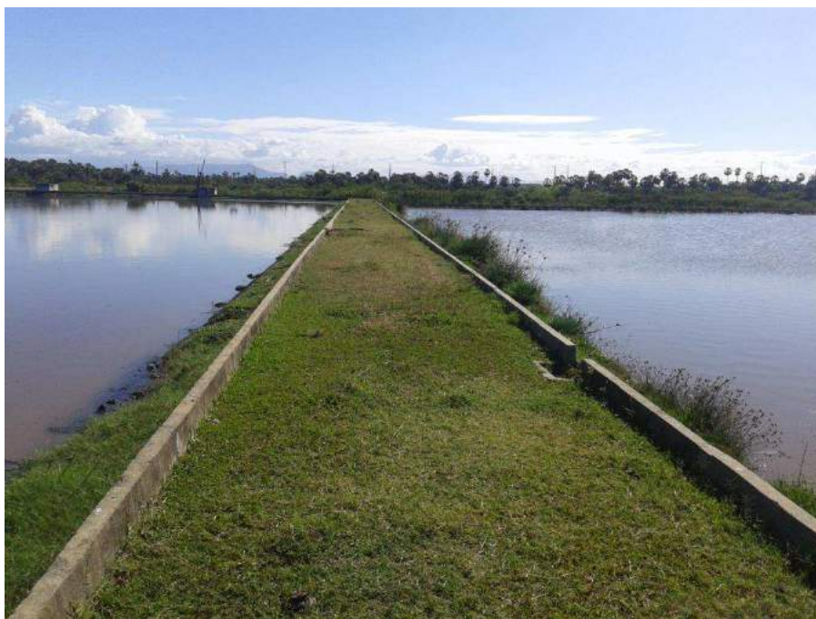
Figura 7.95 – Taludes e coroamento da ETE do Eusébio/CE, localizada no município de Aquiráz/CE.
