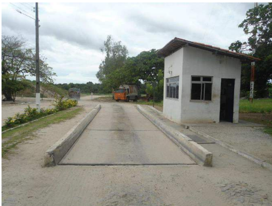
Figura 7.118 – Balança de pesagem de resíduos sólidos do Aterro Sanitário Metropolitano Leste (ASML).
