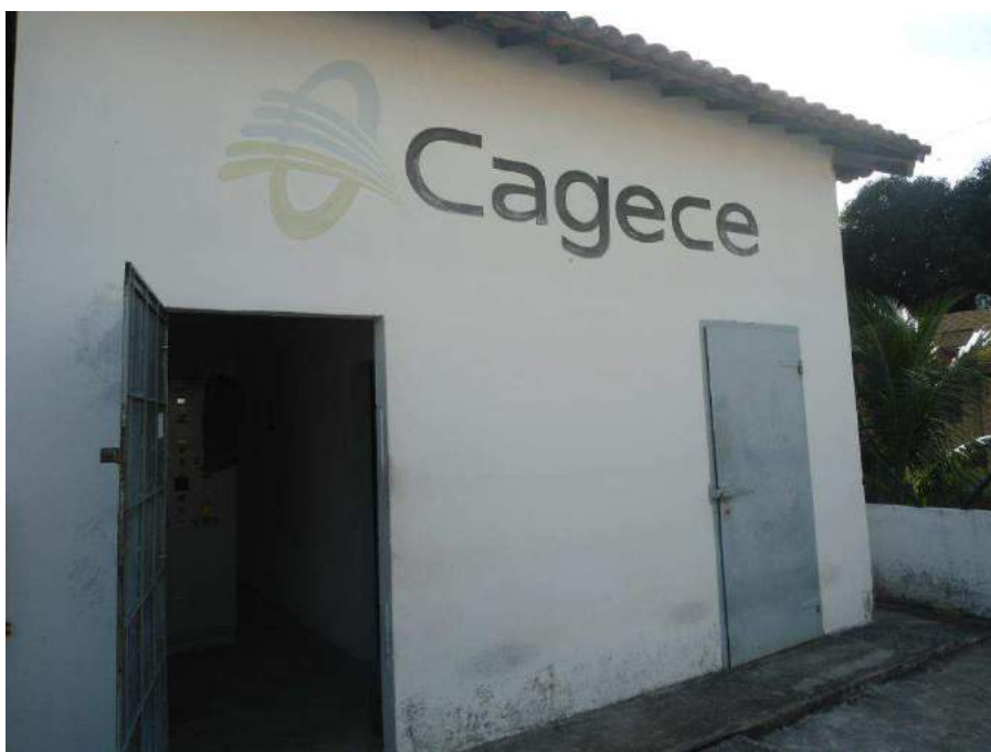
Figura 7.62 – Vista da casa do quadro de comando/gerador da estação elevatória EEE-07 (Rua Irmã Ambrosina – Bairro Centro) do sistema de esgotamento sanitário do Eusébio/CE.
