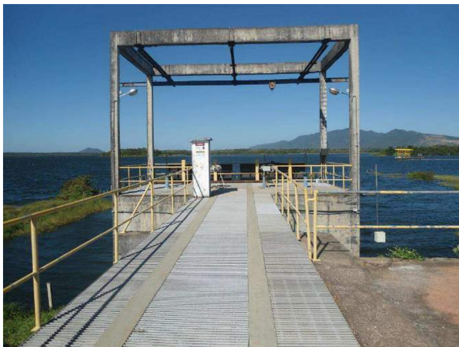
Figura 7.5 – Vista da captação no Açude Gavião.
