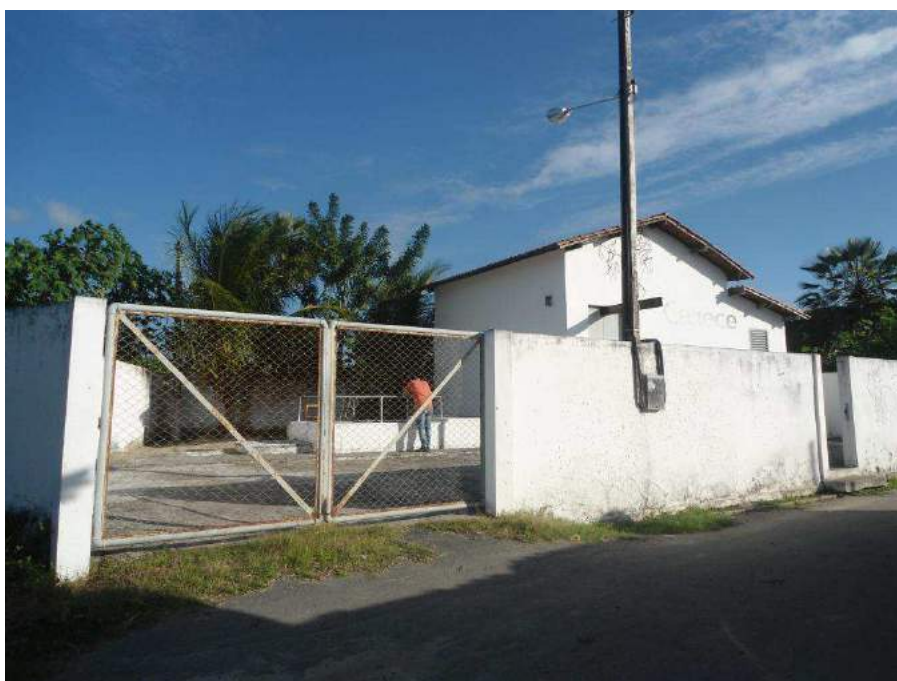
Figura 7.72 – Entrada da estação elevatória EEE-09 (Rua Santo Antônio – Bairro Parque Havaí) do sistema de esgotamento sanitário do Eusébio/CE.
