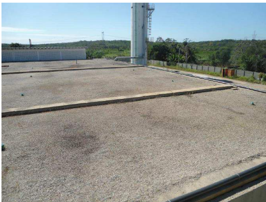
Figura 7.28 – Vista do reservatório semi-enterrado de 35.000 m 3 (RSE).
