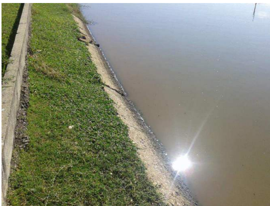
Figura 7.94 – Taludes da ETE do Eusébio/CE, localizada no município de Aquiráz/CE.
