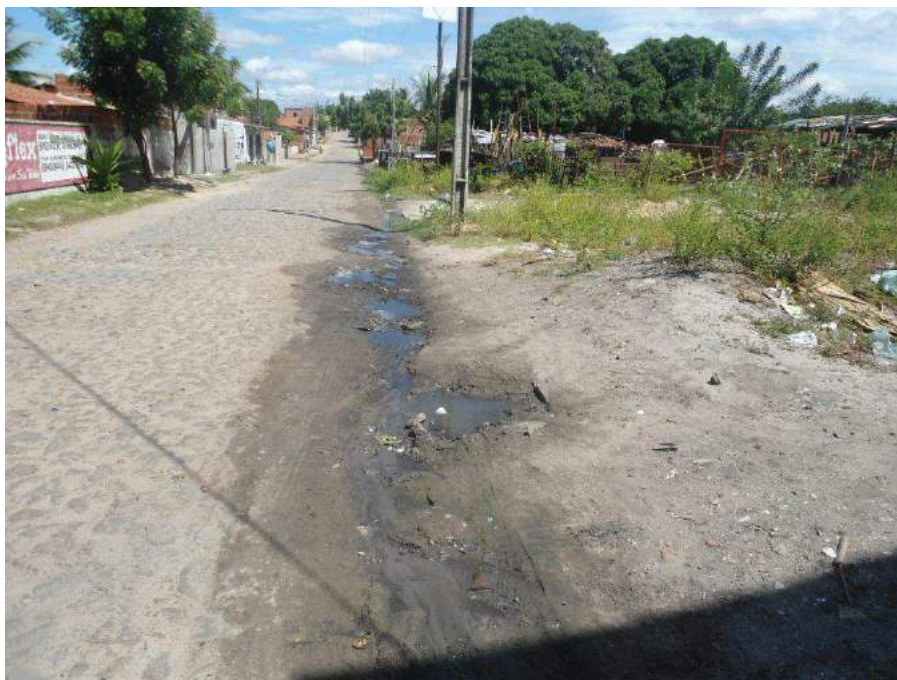
Figura 7.44 – Esgoto a céu aberto.
