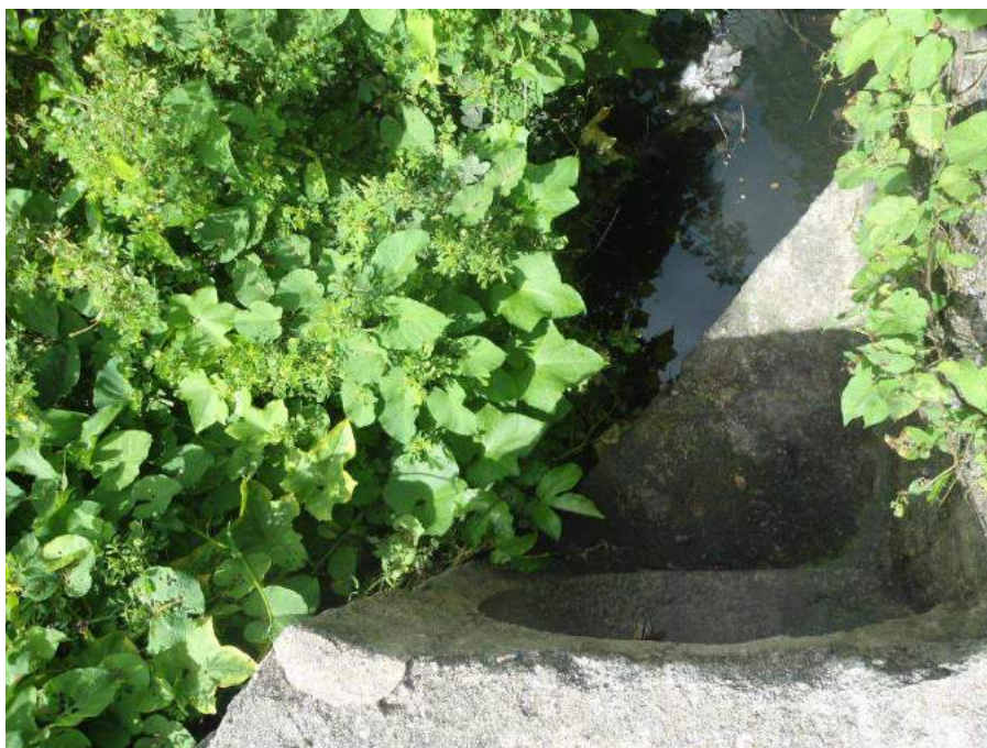
Figura 7.134 – Final da tubulação de drenagem na Praça do Pólo.
