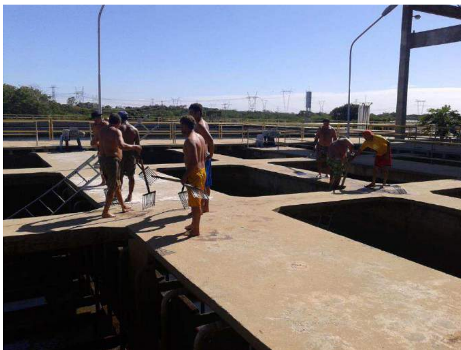
Figura 7.19 – Vista da limpeza manual (rastelamento) dos filtros da ETA.
