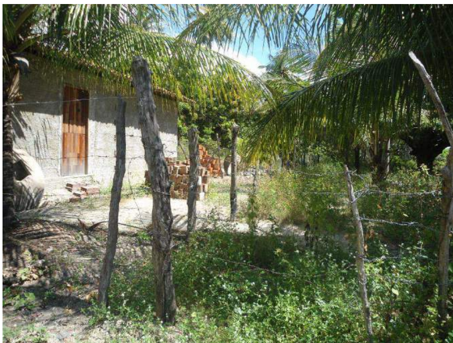
Figura 7.150 – Local onde a Lagoa Precabura, na quadra chuvosa, atinge as residências no Bairro Encantada.
