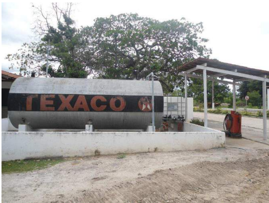
Figura 7.126 – Local para abastecimento de veículos do Aterro Sanitário Metropolitano Leste (ASML).
