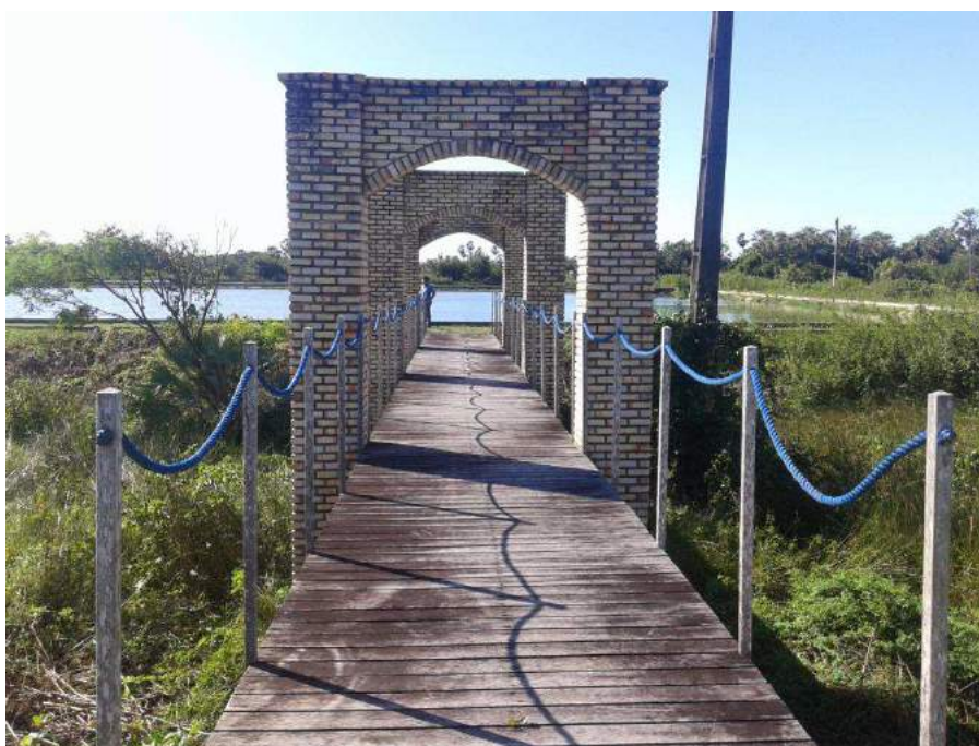
Figura 7.92 – Vista da ponte entre as lagoas de estabilização da ETE do Eusébio/CE, localizada no município de Aquiráz/CE.
