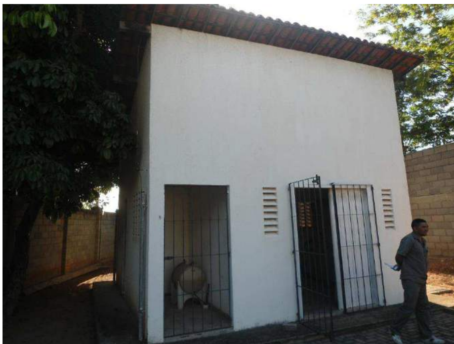
Figura 7.69 – Vista da casa do quadro de comando/gerador da estação elevatória EEE-08 (Rua Beira Rio – Condomínio Jardim Ibiza) do sistema de esgotamento sanitário do Eusébio/CE.
