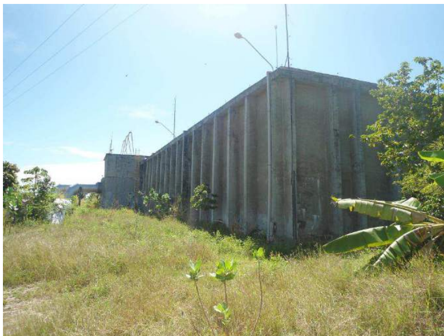
Figura 7.31 – Vista do RAP-Ancuri de 80.000 m 3 .
