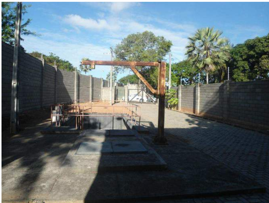
Figura 7.67 – Vista do poço de sucção da estação elevatória EEE-08 (Rua Beira Rio – Condomínio Jardim Ibiza) do sistema de esgotamento sanitário do Eusébio/CE.
