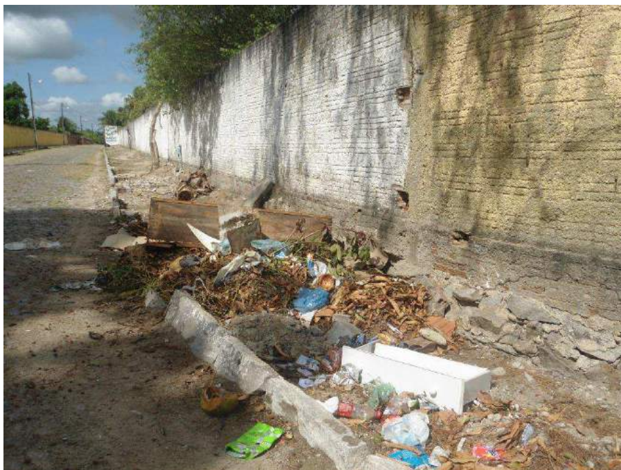
Figura 7.102 – Acúmulo de lixo na sede do município – Eusébio/CE.
