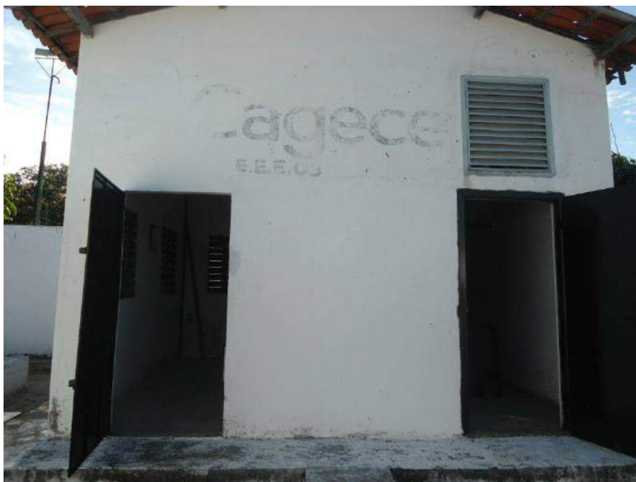
Figura 7.55 – Vista da casa do quadro de comando/gerador da estação elevatória EEE-03 (Rua José Bento – Bairro Guaribas) do sistema de esgotamento sanitário do Eusébio/CE.
