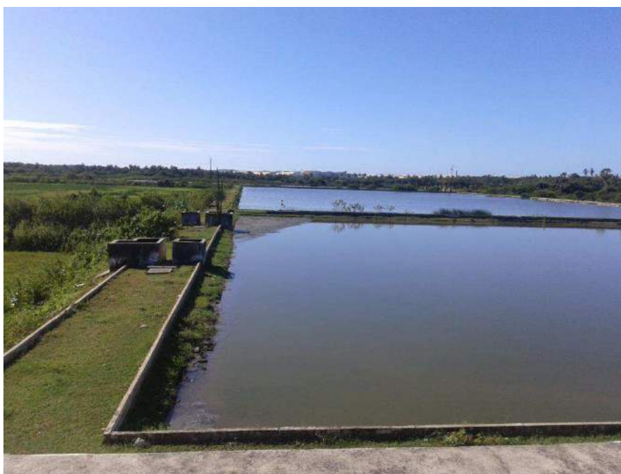
Figura 7.90 – Vista das lagoas de estabilização da ETE do Eusébio/CE, localizada no município de Aquiráz/CE.
