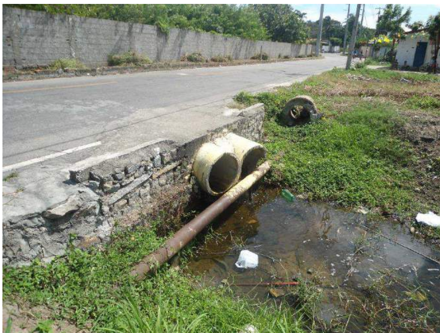
Figura 7.136 – Final da tubulação de drenagem na Rua Blumenau.
