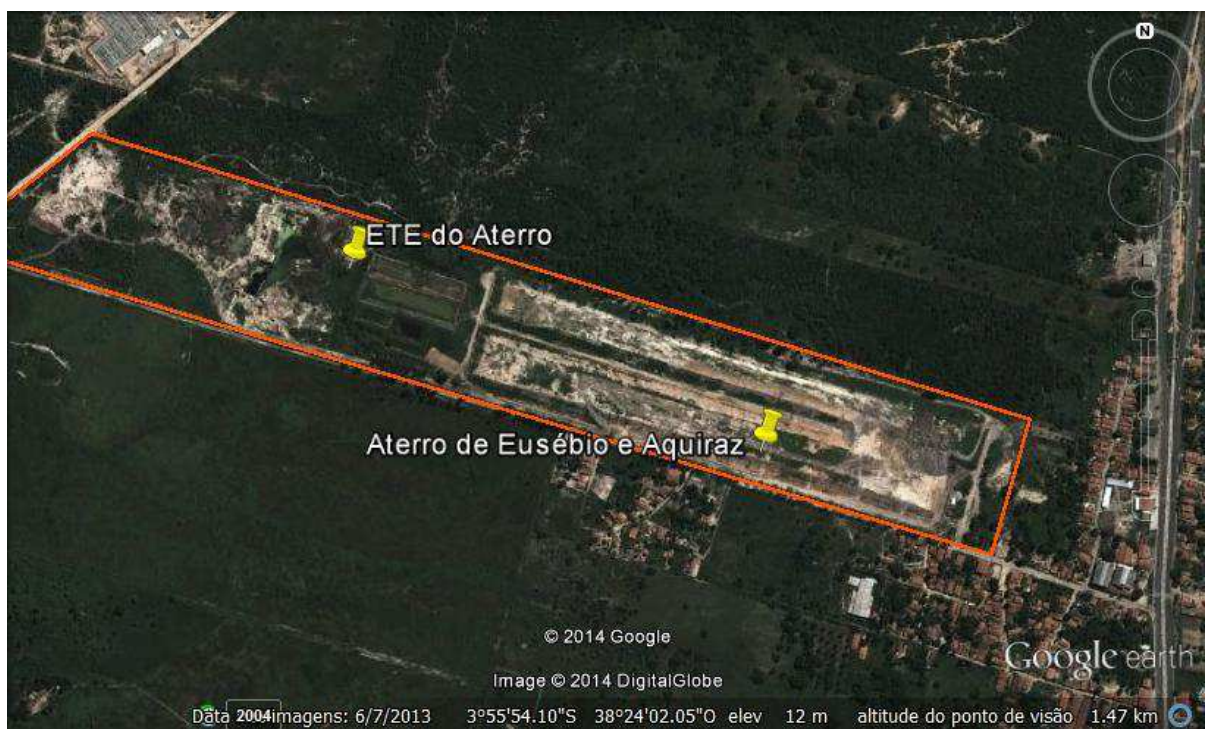
Figura 7.114 – Localização e visão aérea do Aterro Sanitário Metropolitano Leste (ASML ou Aterro).
