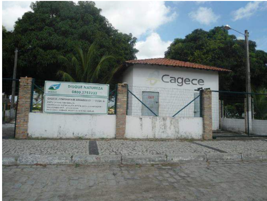
Figura 7.59 – Entrada da estação elevatória EEE-07 (Rua Irmã Ambrosina – Bairro Centro) do sistema de esgotamento sanitário do Eusébio/CE.
