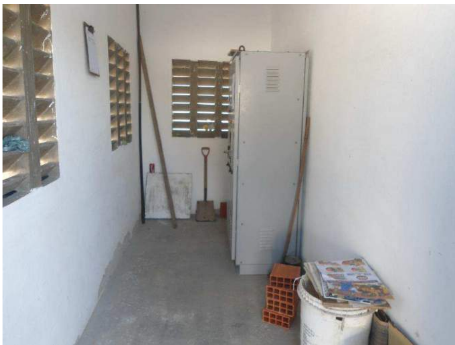
Figura 7.58 – Materiais de limpeza da estação elevatória EEE-03 (Rua José Bento – Bairro Guaribas) do sistema de esgotamento sanitário do Eusébio/CE.
