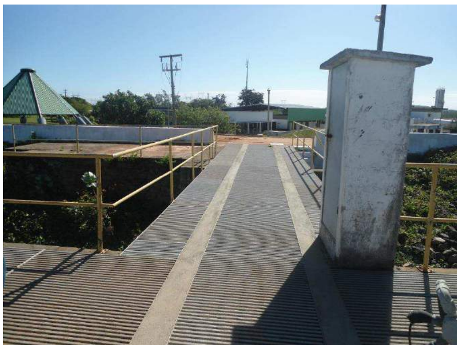
Figura 7.6 – Vista da captação no Açude Gavião.
