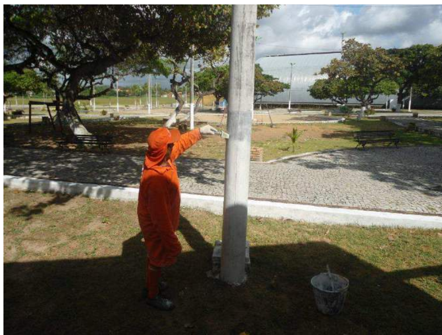
Figura 7.105 – Garis realizando o serviço de pintura de meio-fio/logradouros.
