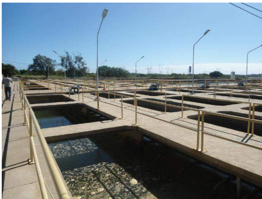
Figura 7.13 – Vista da caixa de passagem (antigo floculador) da ETA.
