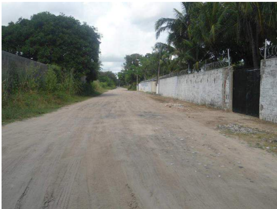
Figura 7.142 – Rua se pavimentação.
