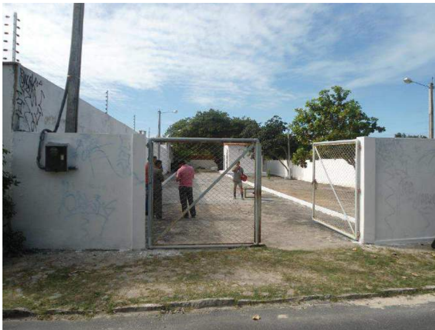
Figura 7.45 – Entrada da estação elevatória EEE-02 (Rua Acilon Gonçalves – Bairro Guaribas) do sistema de esgotamento sanitário do Eusébio/CE.
