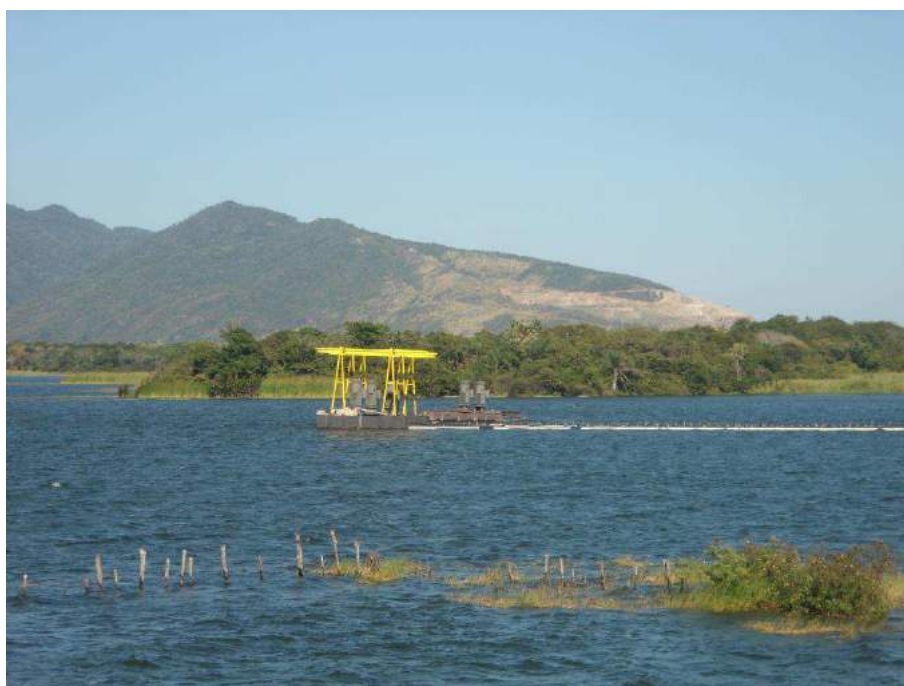
Figura 7.4 – Vista da captação no Açude Gavião.
