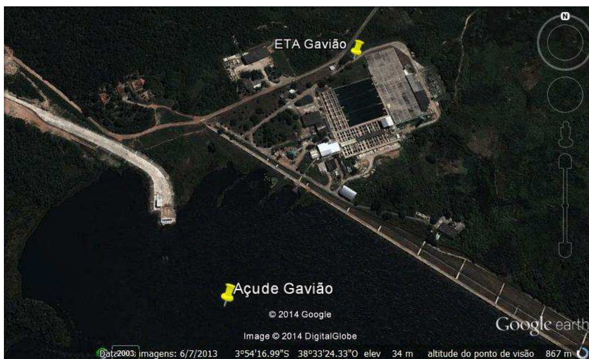
Figura 7.7 – Vista aérea do Açude e da ETA Gavião.
