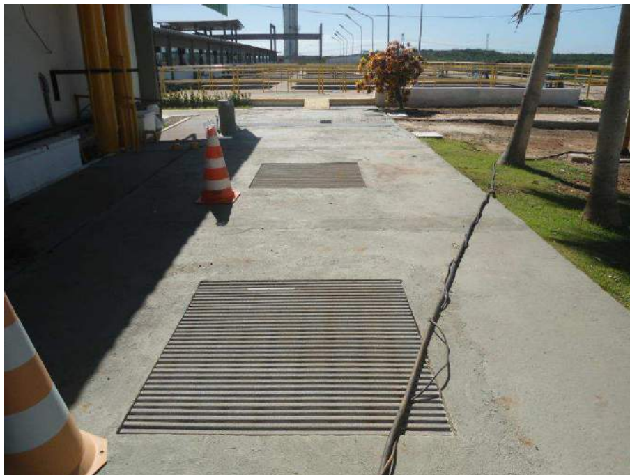
Figura 7.8 – Vista do canal de chegada da água, advinda da captação no Açude Gavião..
