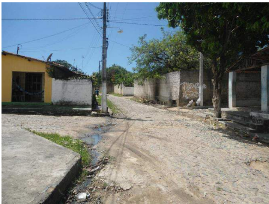
Figura 7.43 – Esgoto a céu aberto no bairro Precabura.
