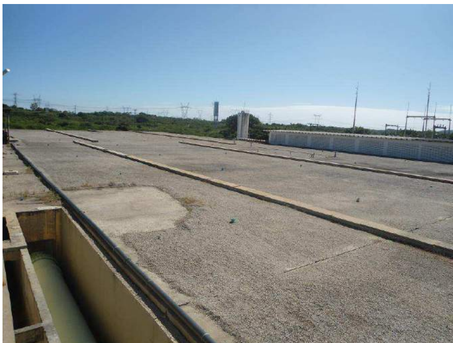
Figura 7.27 – Vista do reservatório semi-enterrado de 35.000 m 3 (RSE).
