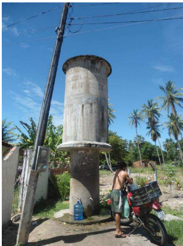
Figura 7.34 – Vista do chafariz no bairro Olho D'Água.
