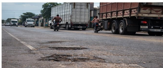
Caminhões e veículos pesados no trecho urbano da BR-070 (Avenida São Luiz) no município de Cáceres-MT, onde há grande fluxo devido à
