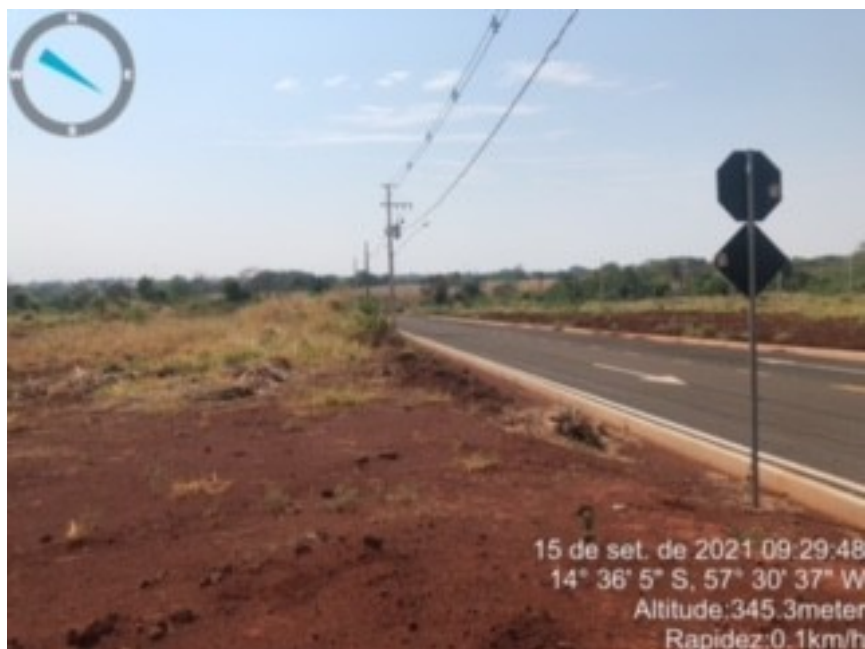
Figura 02 - Vista do imóvel
