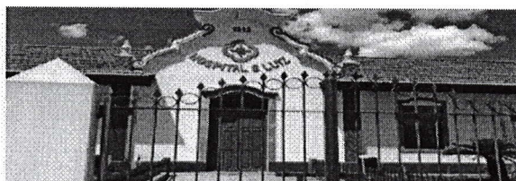
Hospital São Luiz em Cáceres - Foto: Cuiabá/MT/MTV
