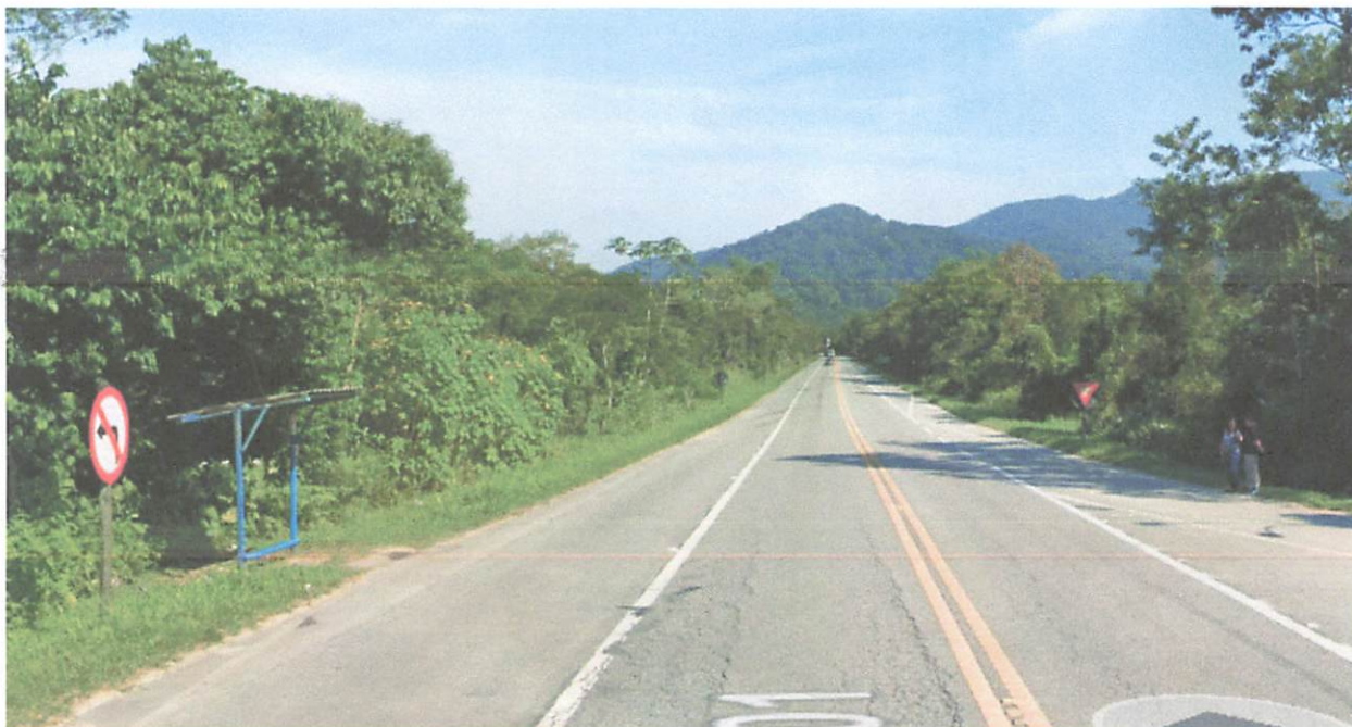
Trecho do Caiubura que precisa urgente de iluminação
