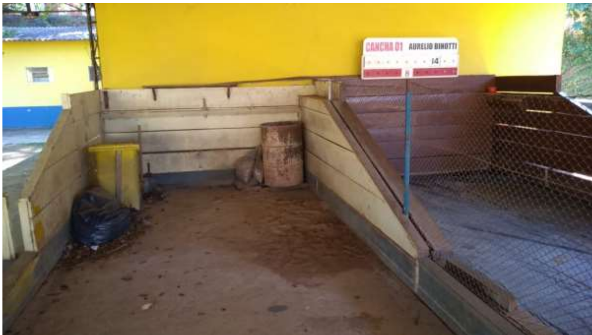
Cancha de Bocha para reforma
