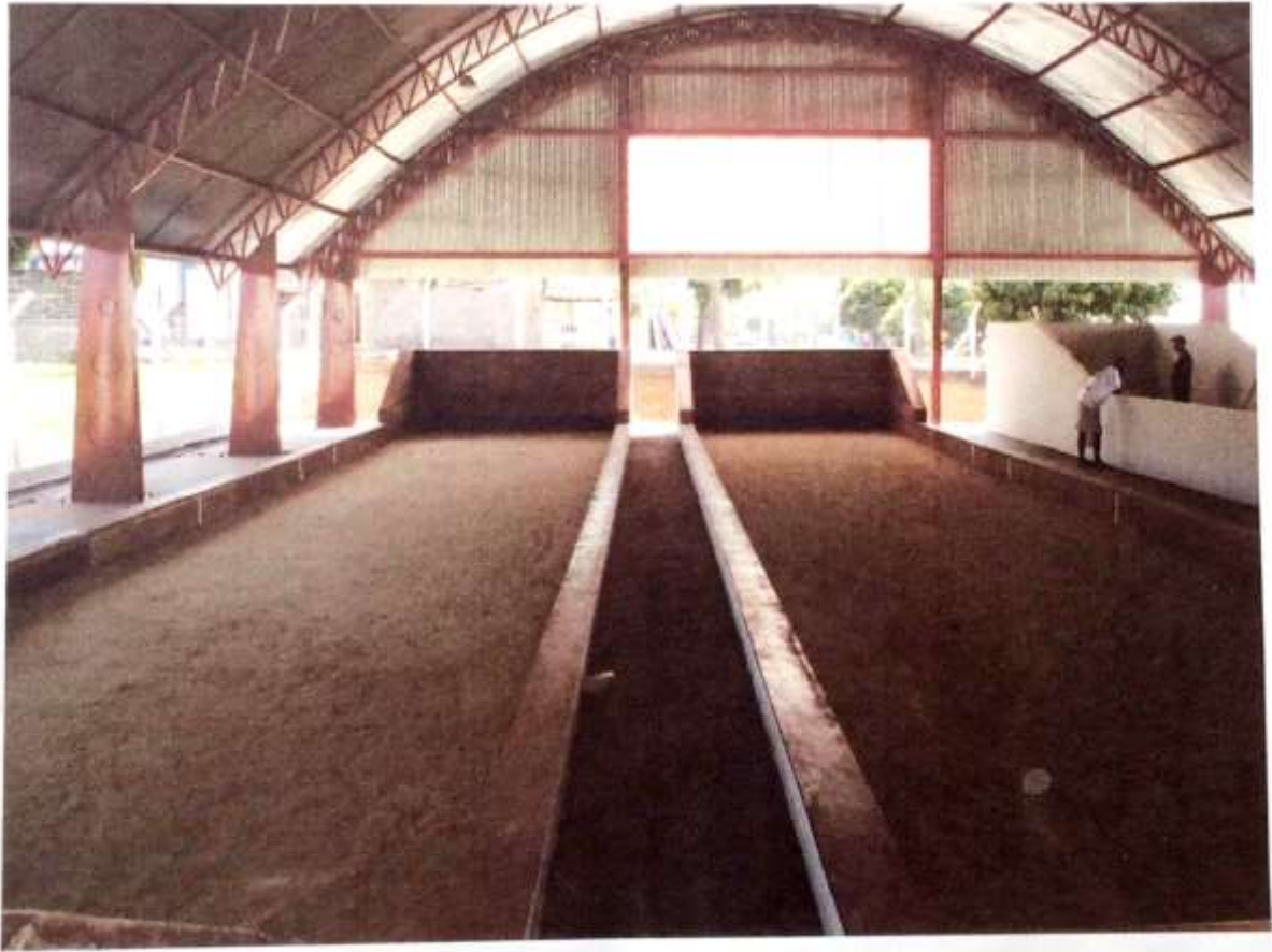
Canha de Bocha a ser construída
