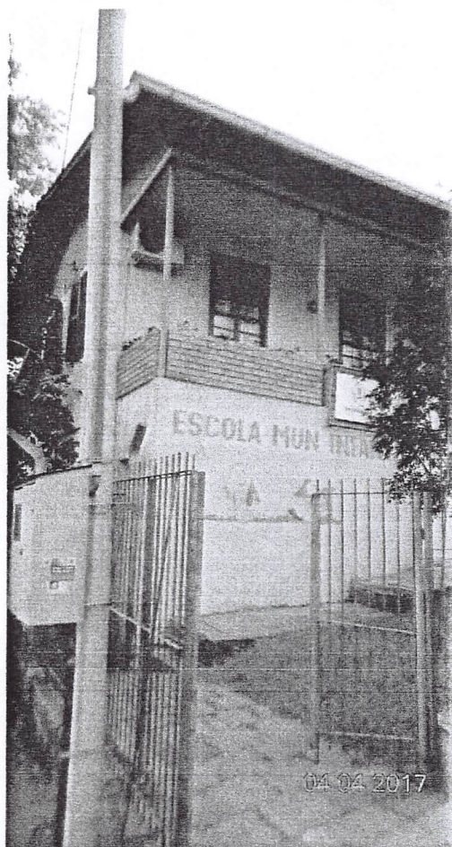
Foto 21 – imagem do acesso secundário da edificação;
