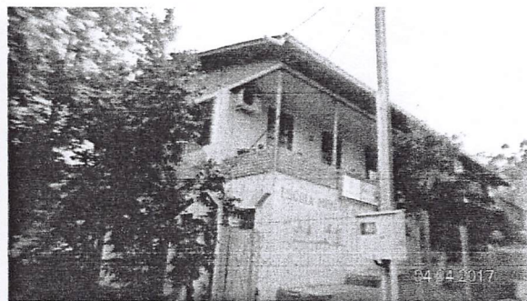
Foto 02 – imagem da fachada principal - sul;
