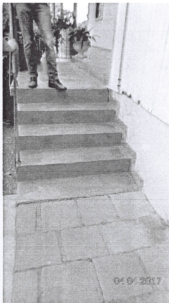
Foto 18 – imagem do principal acesso da edificação;
