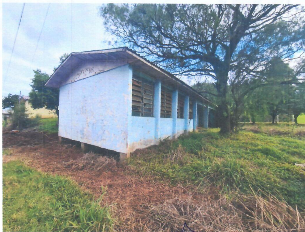
Foto 17-Fachada Sudoeste da Edificação
