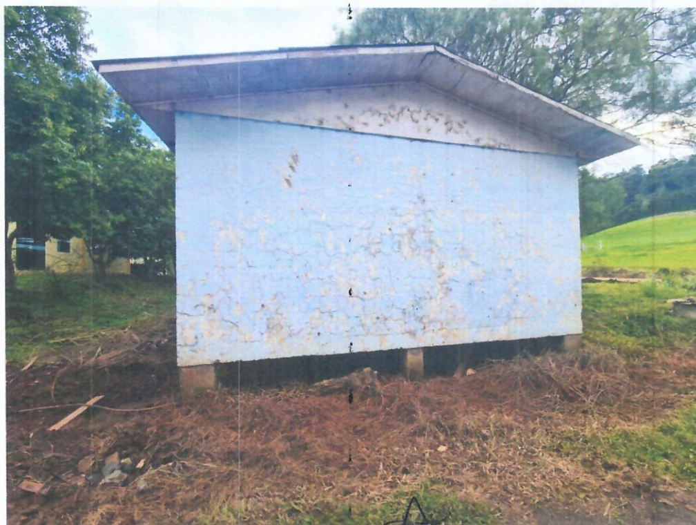
Foto 19-Fachada Sudoeste da Edificação
