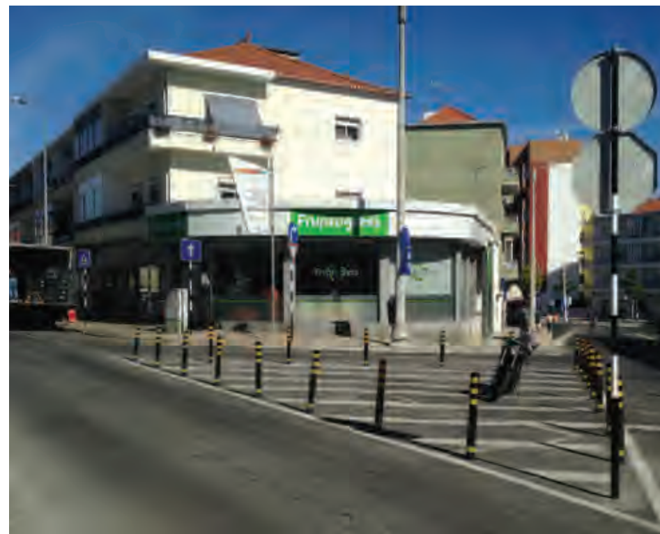
Imagem 80: Exemplo de balizadores para a redução de velocidades e organização do tráfego de veículos. Fonte: TC Urbes
