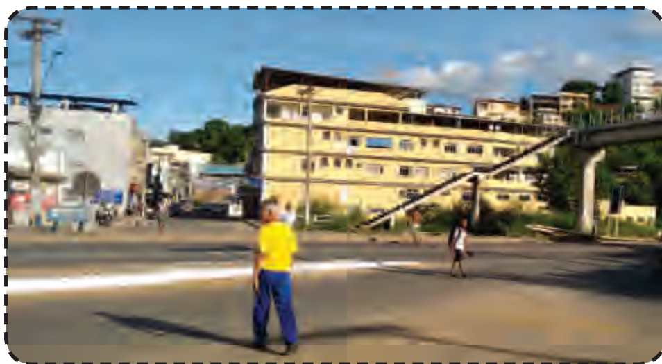
Imagem 21: Travessia elevada na BR 116 e pedestres atravessando em nível.
