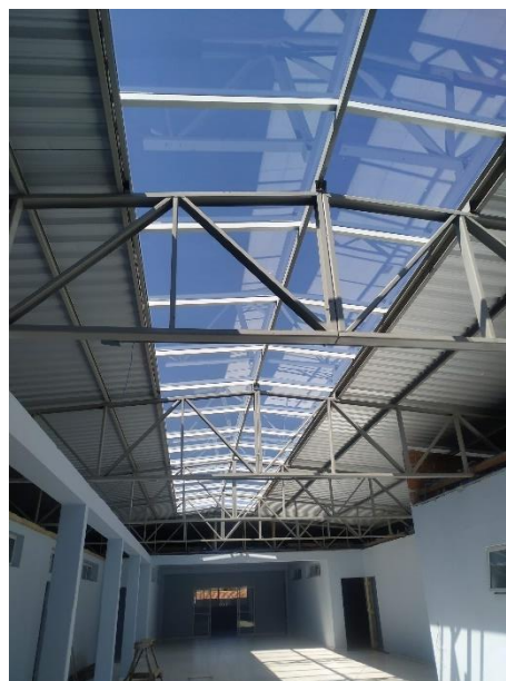
Pátio cobertura metálica
