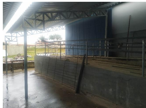
Cobertura metálica para acesso a quadra
