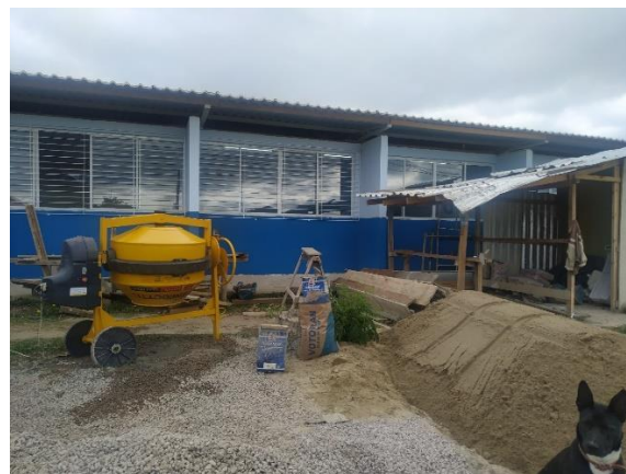
Pintura, telhado e esquadrias novos
