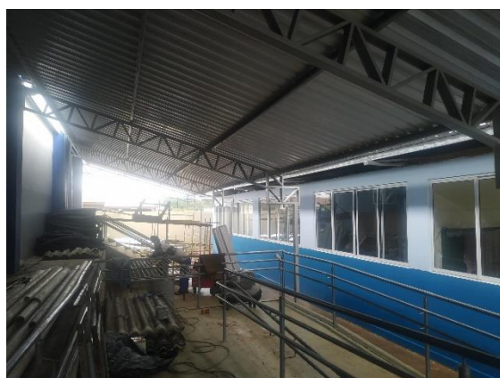
Cobertura metálica para acesso a quadra
