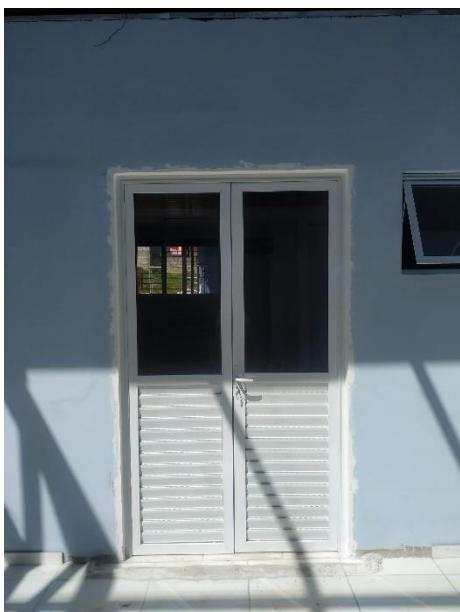
Porta nova instalada no refeitório
