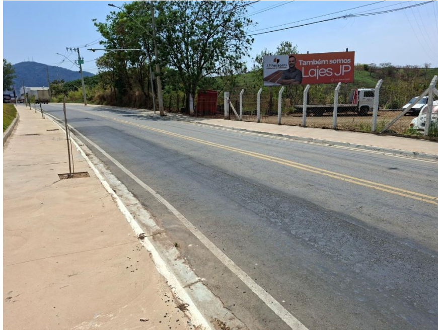
Imagem 13: Reparos realizados em trecho do pavimento asfáltico da avenida, com recomposição de trechos da sinalização horizontal. – Arquivo da Secretaria Municipal de Planejamento Urbano e Meio Ambiente.
