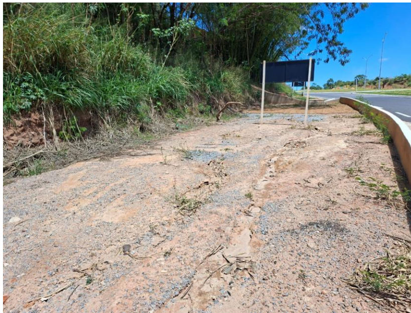
Imagem 29: Local onde foi realizado o plantio de grama nas proximidades da escada hidráulica. – Arquivo da Secretaria Municipal de Planejamento Urbano e Meio Ambiente.
