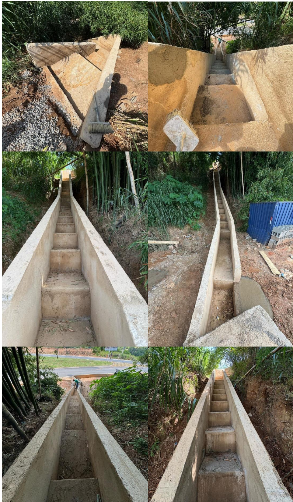
Fotos da descida em degraus:
