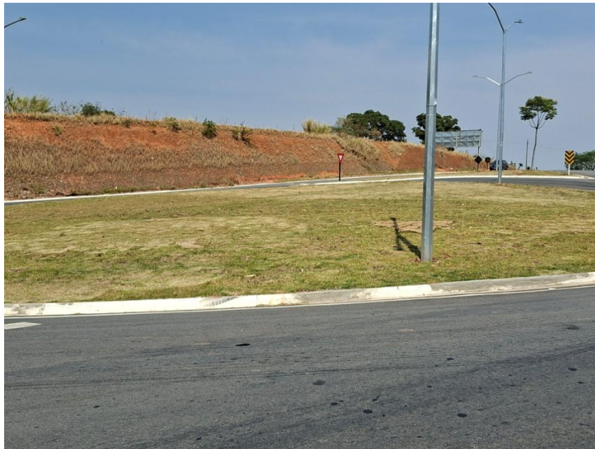
Imagem 04: Reparos efetuados nos meios-fios nas proximidades do trevo. – Arquivo da Secretaria Municipal de Planejamento Urbano e Meio Ambiente.
