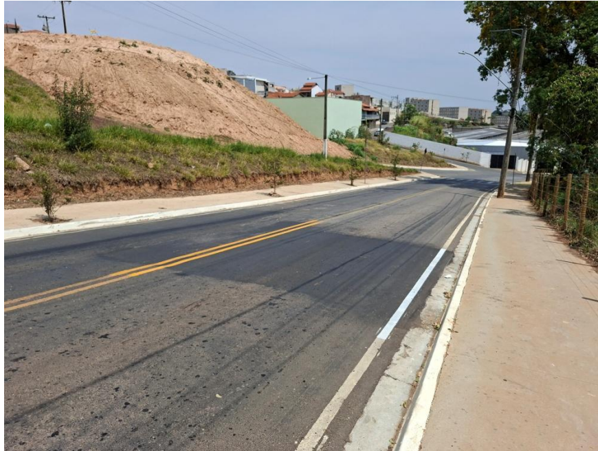
Imagem 19: Reparos realizados em trecho do pavimento asfáltico da avenida, com recomposição de trechos da sinalização horizontal. – Arquivo da Secretaria Municipal de Planejamento Urbano e Meio Ambiente.
