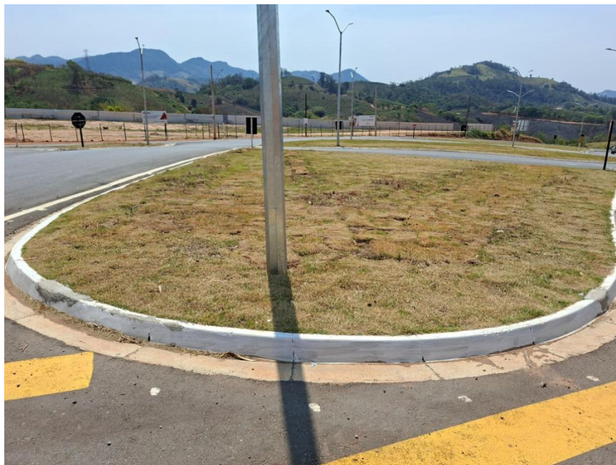
Imagem 02: Reparos efetuados nos meios-fios nas proximidades do trevo. – Arquivo da Secretaria Municipal de Planejamento Urbano e Meio Ambiente.
