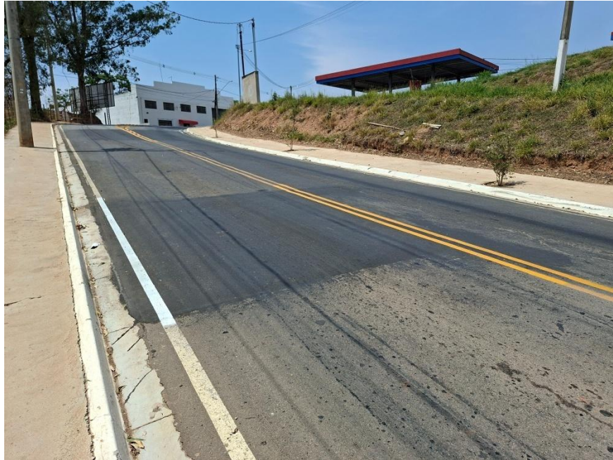
Imagem 21: Reparos realizados em trecho do pavimento asfáltico da avenida, com recomposição de trechos da sinalização horizontal. – Arquivo da Secretaria Municipal de Planejamento Urbano e Meio Ambiente.
