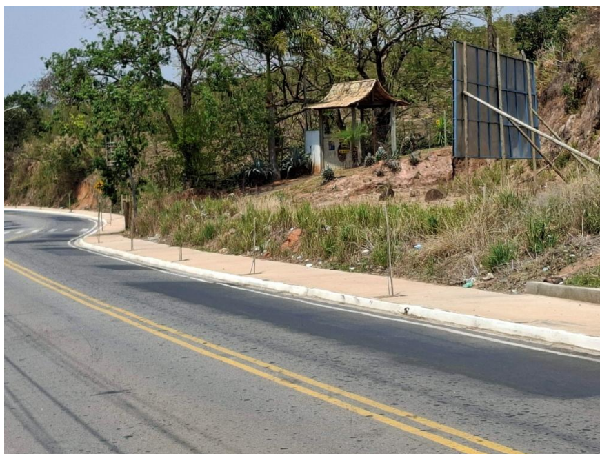
Imagem 12: Reparos realizados em trecho do pavimento asfáltico da avenida, com recomposição de trechos da sinalização horizontal. – Arquivo da Secretaria Municipal de Planejamento Urbano e Meio Ambiente.
