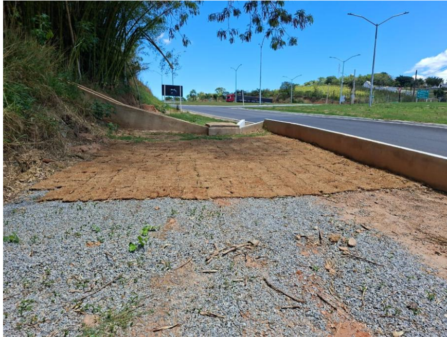
Imagem 28: Local onde foi realizado o plantio de grama nas proximidades da escada hidráulica. – Arquivo da Secretaria Municipal de Planejamento Urbano e Meio Ambiente.
