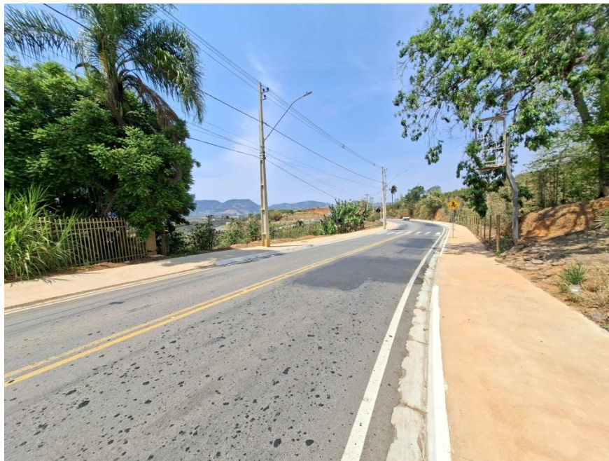
Imagem 11: Reparos realizados em trecho do pavimento asfáltico da avenida, com recomposição de trechos da sinalização horizontal. – Arquivo da Secretaria Municipal de Planejamento Urbano e Meio Ambiente.
