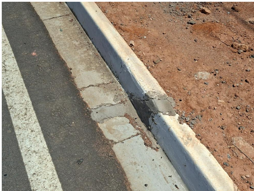
Imagem 06: Reparos efetuados nos meios-fios em trecho da avenida. – Arquivo da Secretaria Municipal de Planejamento Urbano e Meio Ambiente.
