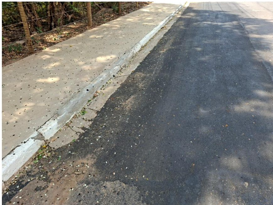
Imagem 22: Reparos efetuados nos meios-fios em trecho da avenida. – Arquivo da Secretaria Municipal de Planejamento Urbano e Meio Ambiente.
