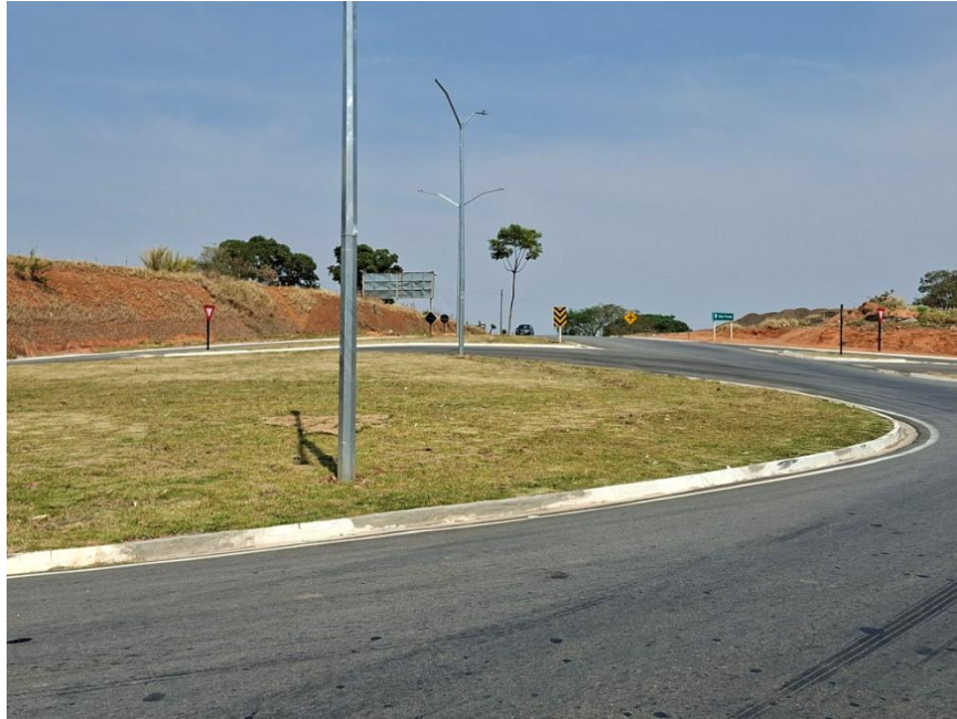
Imagem 05: Reparos efetuados nos meios-fios nas proximidades do trevo. – Arquivo da Secretaria Municipal de Planejamento Urbano e Meio Ambiente.
