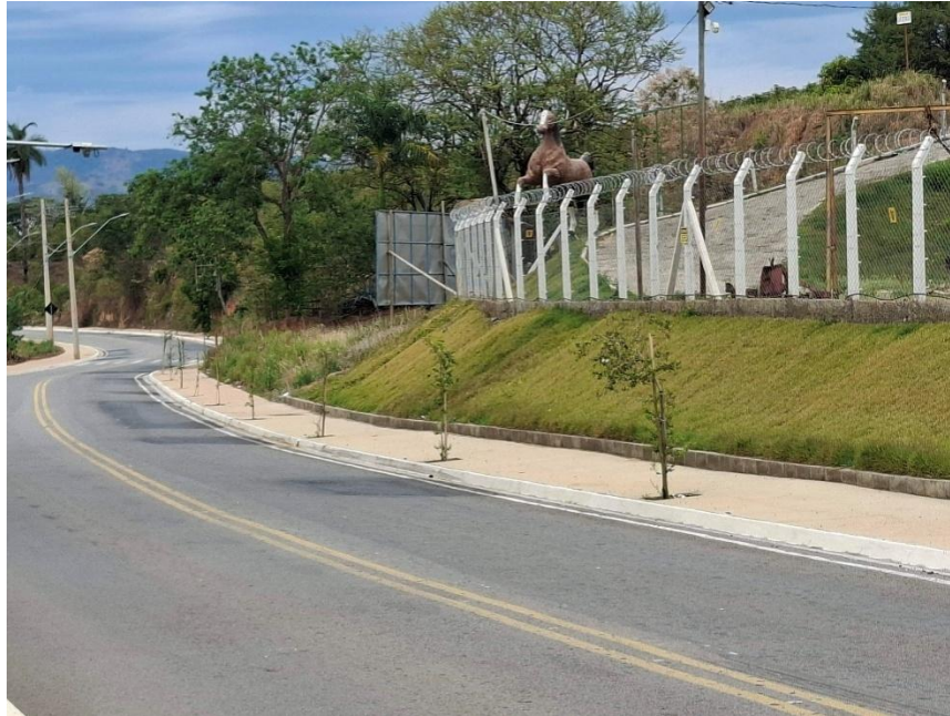
Imagem 15: Substituição de mudas do paisagismo da avenida e reparos realizados em trecho do pavimento asfáltico da avenida. – Arquivo da Secretaria Municipal de Planejamento Urbano e Meio Ambiente.
