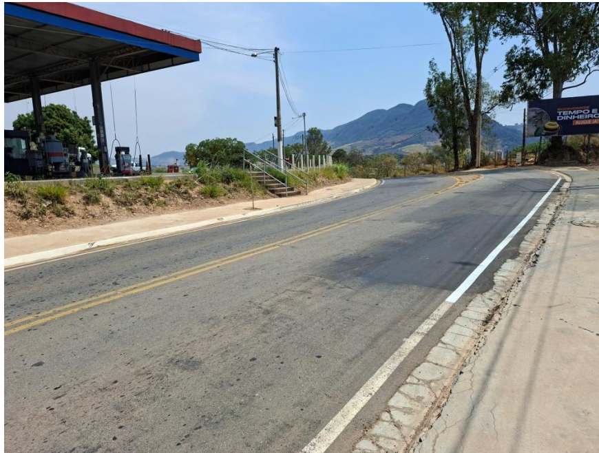
Imagem 17: Reparos realizados em trecho do pavimento asfáltico da avenida, com recomposição de trechos da sinalização horizontal. – Arquivo da Secretaria Municipal de Planejamento Urbano e Meio Ambiente.
