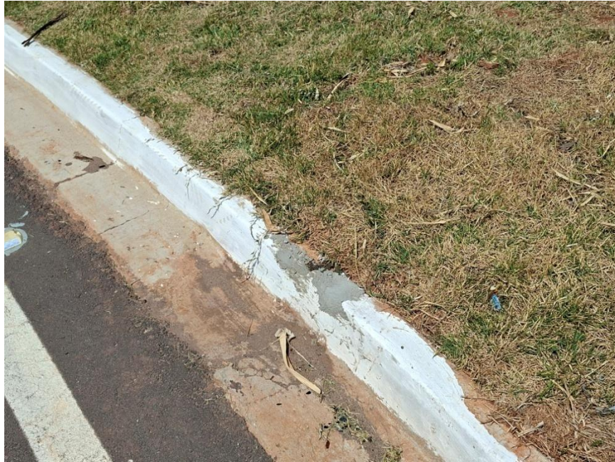
Imagem 03: Reparos efetuados nos meios-fios nas proximidades do trevo. – Arquivo da Secretaria Municipal de Planejamento Urbano e Meio Ambiente.
