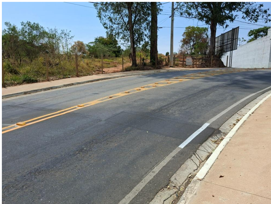
Imagem 18: Reparos realizados em trecho do pavimento asfáltico da avenida, com recomposição de trechos da sinalização horizontal. – Arquivo da Secretaria Municipal de Planejamento Urbano e Meio Ambiente.
