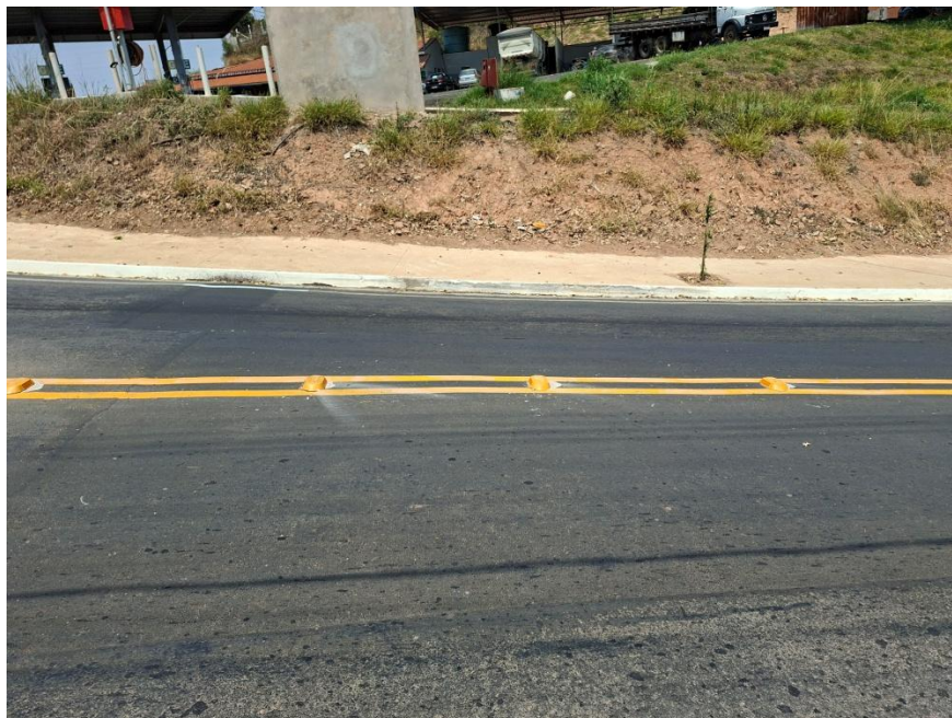
Imagem 20: Reparos realizados em trecho do pavimento asfáltico da avenida, com recomposição de trechos da sinalização horizontal. – Arquivo da Secretaria Municipal de Planejamento Urbano e Meio Ambiente.
