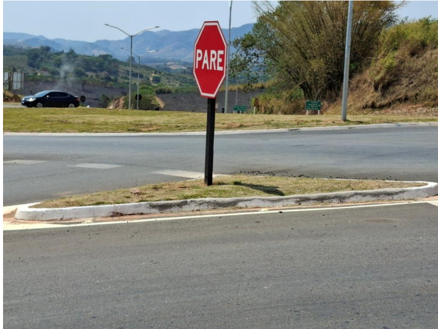
Imagem 01: Reparos efetuados nos meios-fios nas proximidades do trevo. – Arquivo da Secretaria Municipal de Planejamento Urbano e Meio Ambiente.
