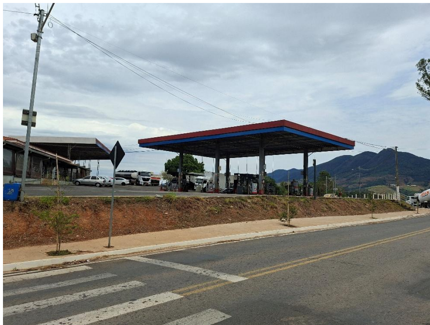
Imagem 16: Substituição de mudas do paisagismo da avenida e reparos realizados em trecho do pavimento asfáltico da avenida. – Arquivo da Secretaria Municipal de Planejamento Urbano e Meio Ambiente.
