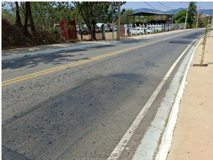
Imagem 14: Reparos realizados em trecho do pavimento asfáltico da avenida, com recomposição de trechos da sinalização horizontal. – Arquivo da Secretaria Municipal de Planejamento Urbano e Meio Ambiente.
