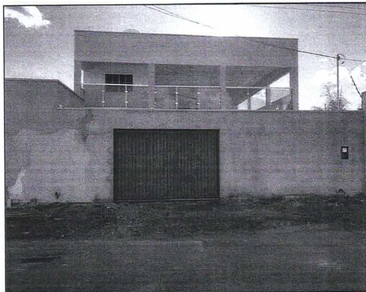
Figura 1 - Vista frontal da edificação com frente para Rua W. Soares
