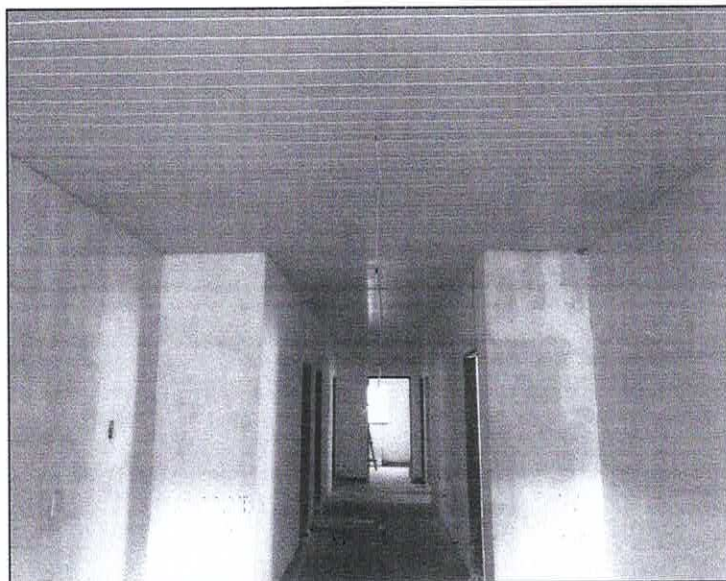
Figura 21 - Forro do térreo em PVC, em boas condições
