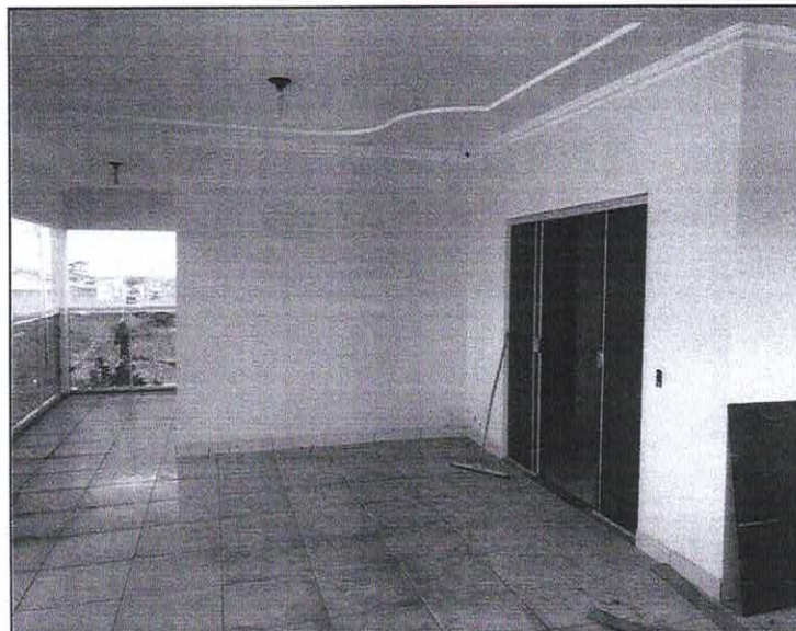
Figura 11 - Alvenaria em boas condições
