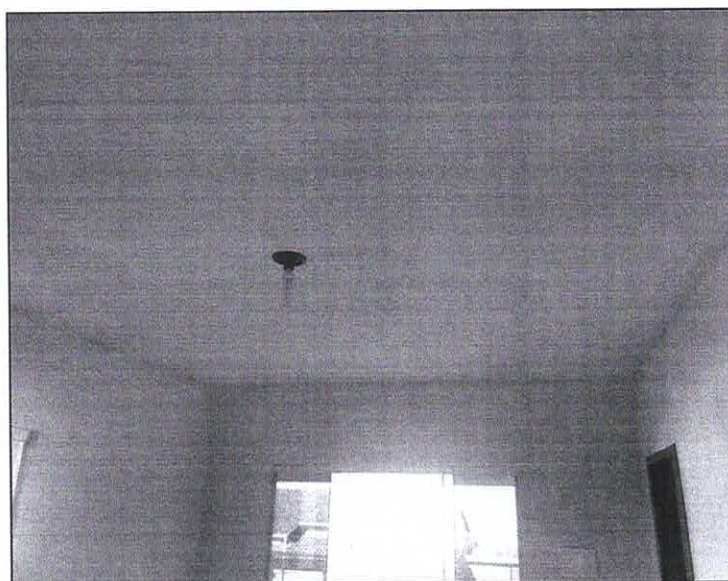
Figura 22 - Forro superior em gesso, em boas condições
