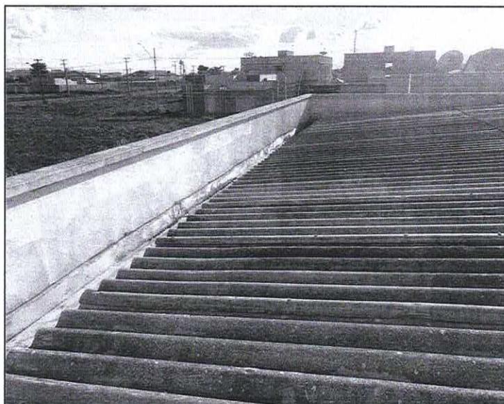
Figura 7 - Vista da cobertura e calha
