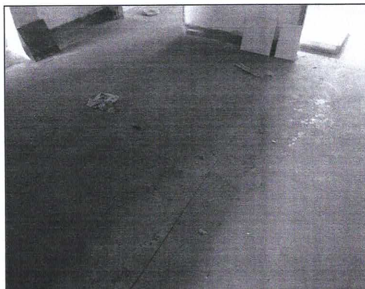
Figura 18 - Piso do térreo em granitina em boas condições
