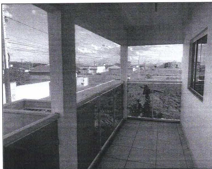
Figura 5 - Vista pilares, vigas sem patologias
