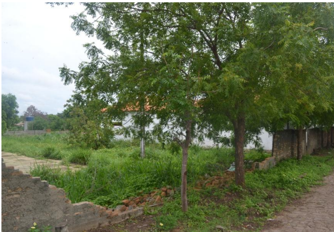
Muro da Unidade Escolar Maria Machado de Cerqueira
