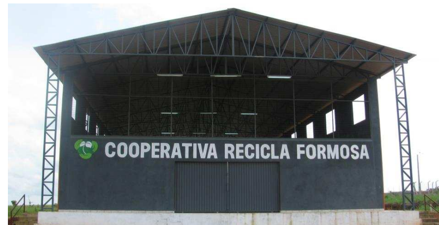
Figura 6: Galpão finalizado e em operação (fevereiro de 2013) Fonte: Cooperativa Recicla Formosa
