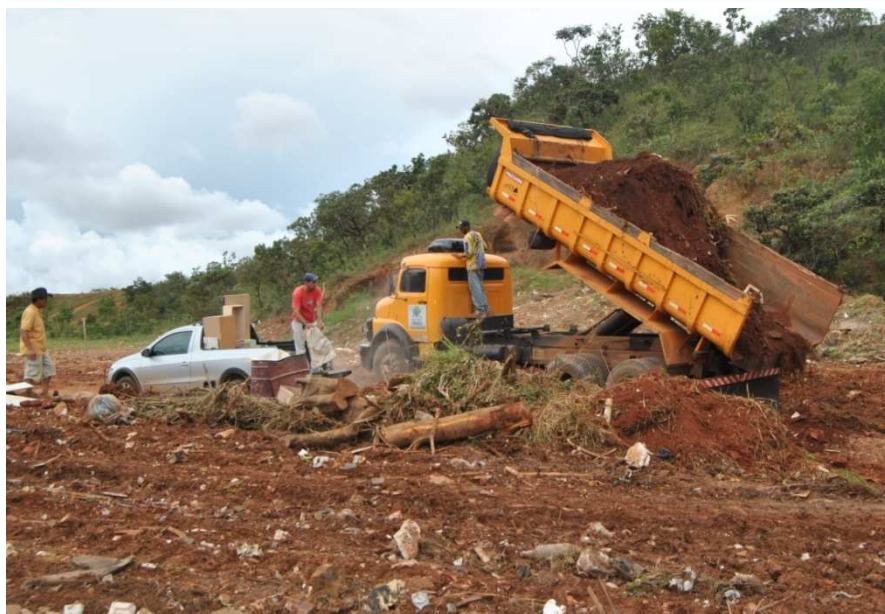
Figura 43: Caminhão depositando material no Aterro de Inertes Fonte: Ypê Amarelo abril 2013
