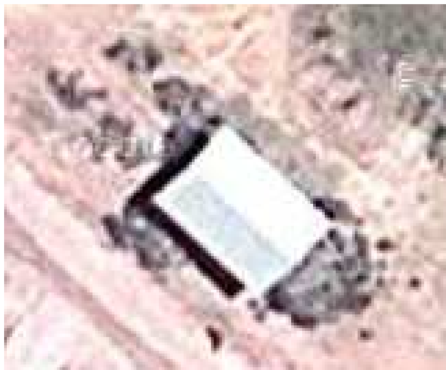
Figura 30: Depósito de Pneumáticos no Aterro Municipal – Imagem Aérea Foto: Google Maps 2011
