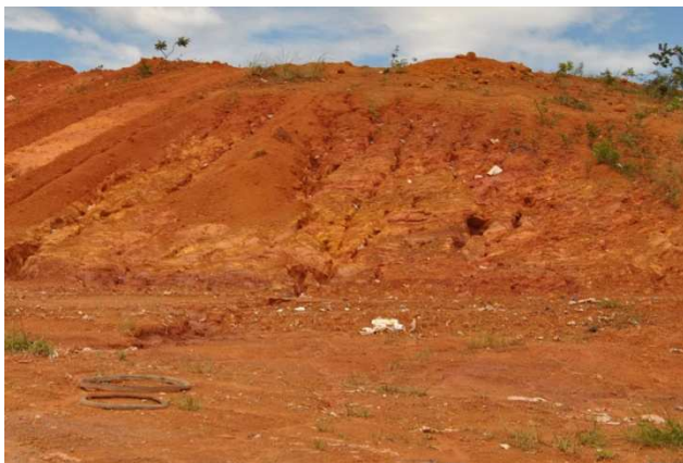
Figura 28: Erosão no Aterro Municipal
