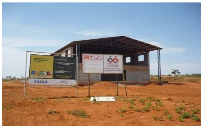
Figura 5: Galpão em construção Fonte: Cooperativa Recicla Formosa
