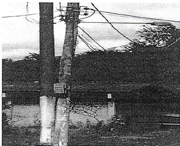
Troca dos postes de madeira e da fiação elétrica
