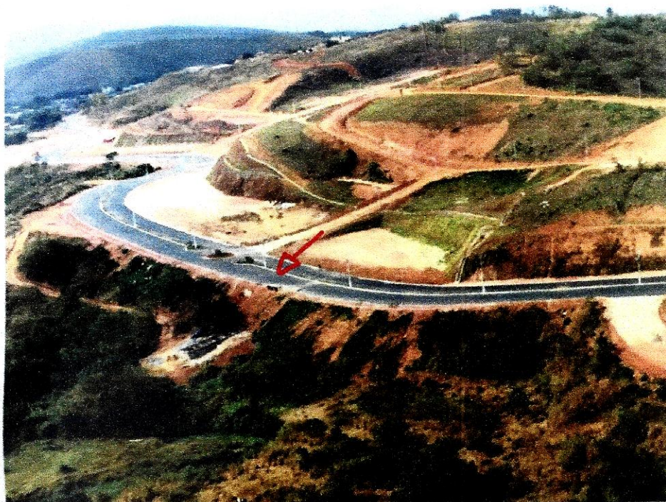
Avenida Dr. Lelé construída pela administração 2013 a 2016 e o trecho citado acima que necessita de intervenção.
