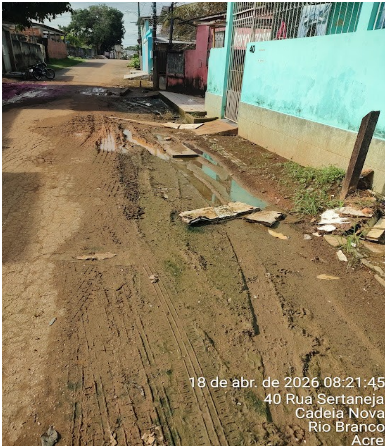
Trecho da Rua Sertaneja: pavimentação, calçada, meio fio, drenagem
