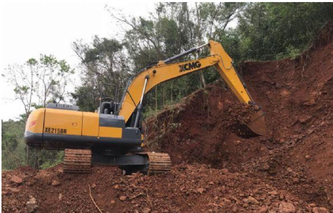
Figura 1 - Exemplo de escavação por escavadeira hidráulica em talude
