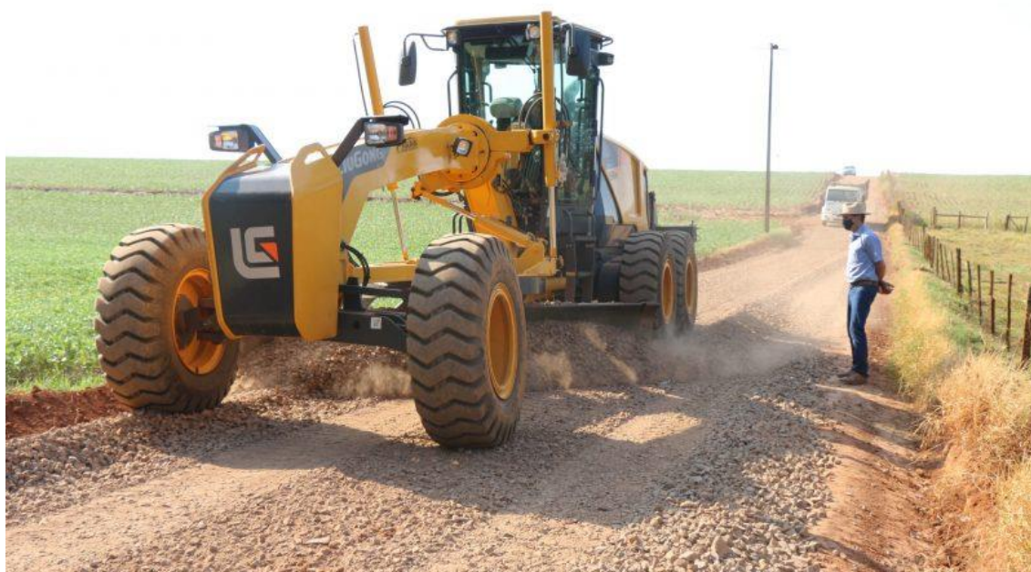
Figura 3 - Serviço de espalhamento do material granular
