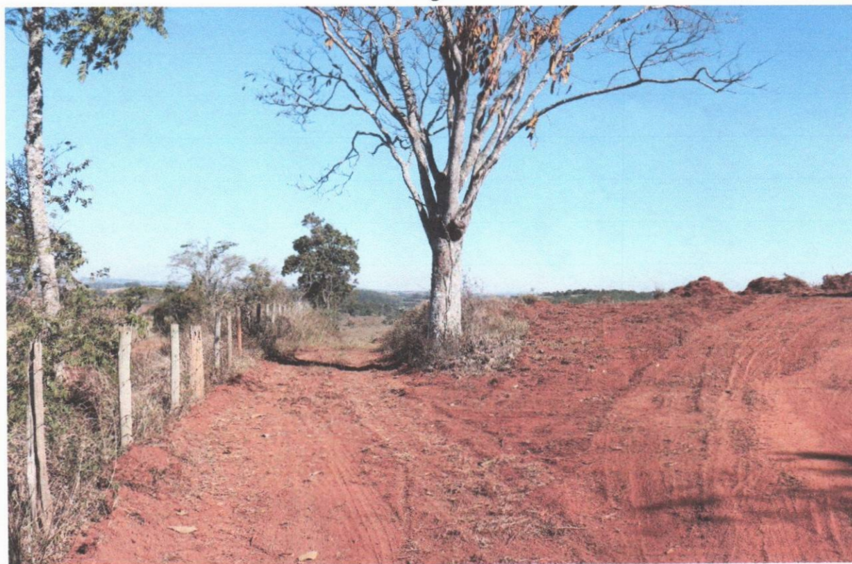
Foto 12 - Entroncamento da nova estrada com a via de acesso do Bairro Castro à comunidade Olhos D'Água
