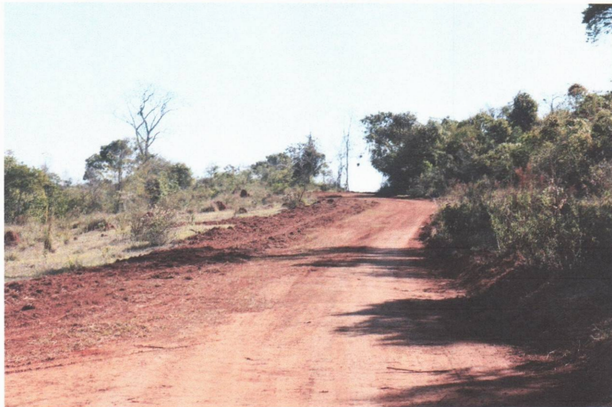
Foto 11 - Ponto final da nova estrada aberta pelo Município, próximo do entroncamento com a via que liga o Castro à comunidade dos Olhos D'água (acesso à fazenda Samaipata)
