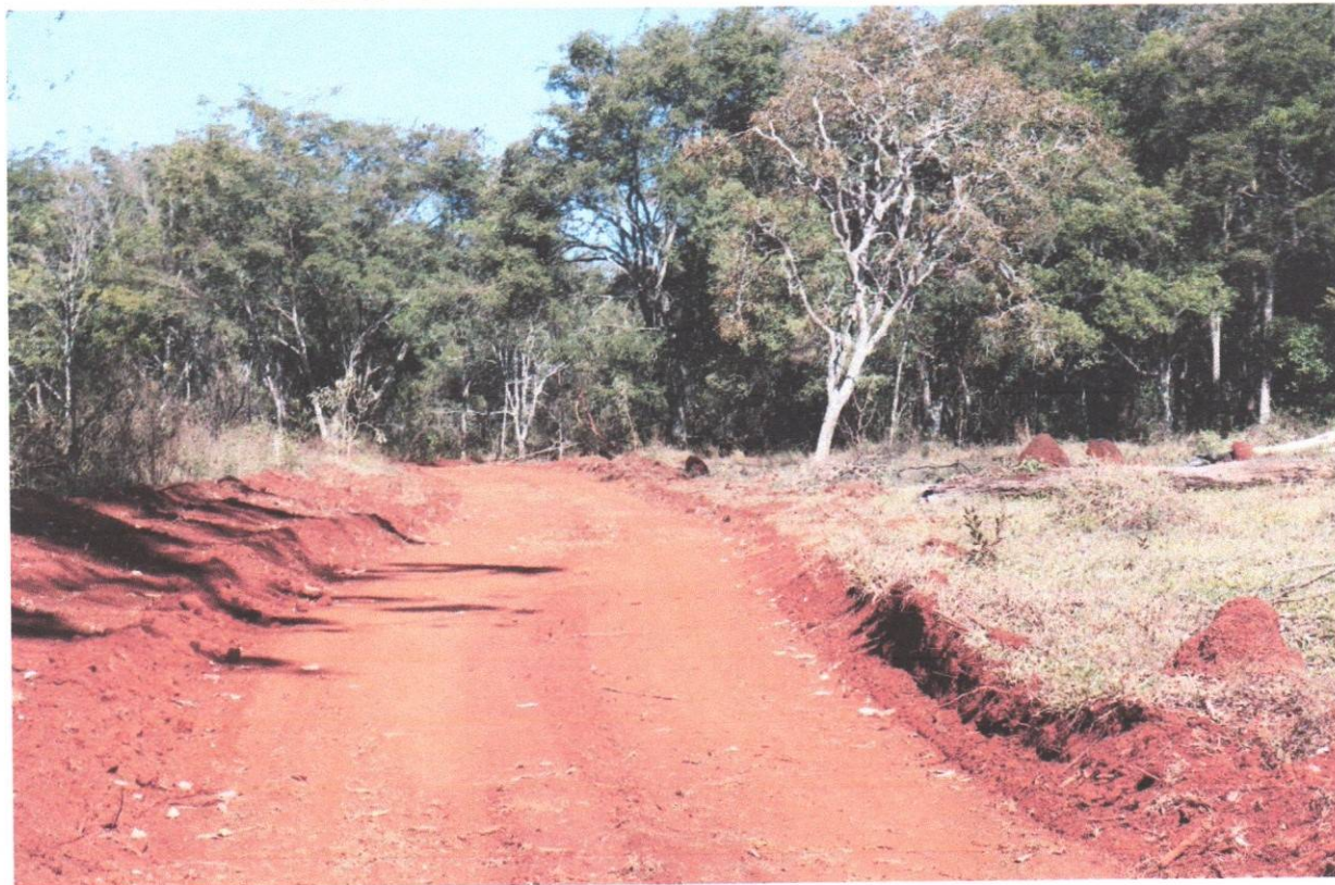
Foto 10 - Continuidade da estrada aberta pelo Município
