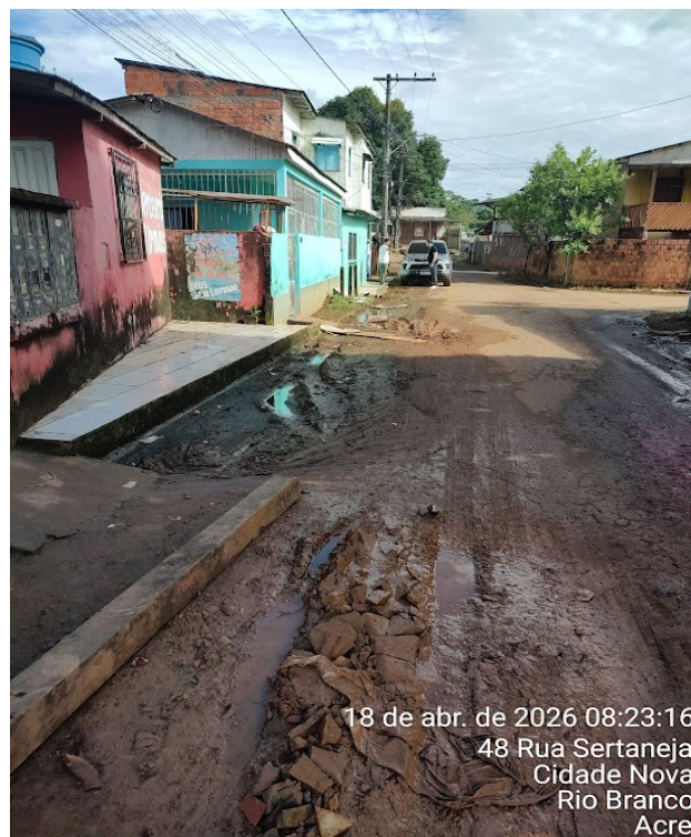
Trechos com transbordamento por problema na drenagem, pavimentação, calçada, meio-fio
