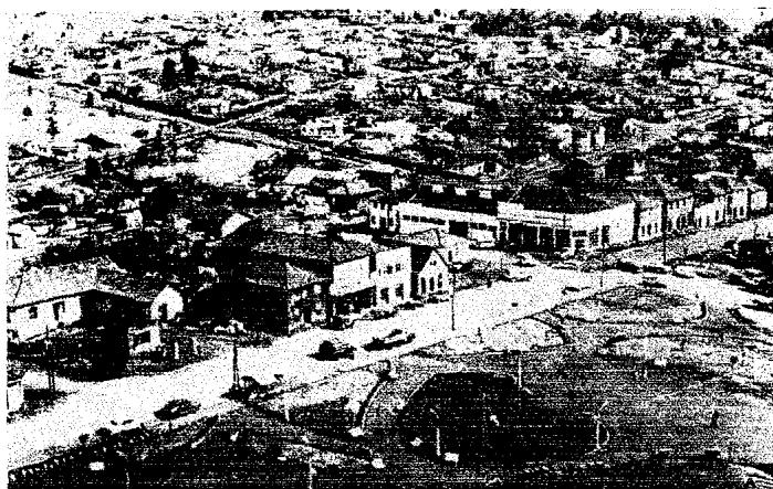
1964-Uma visão parcial da praça e do setor oeste da cidade. A imagem foi registrada por José Zanella, da torre da nova igreja, então em fase de construção.
