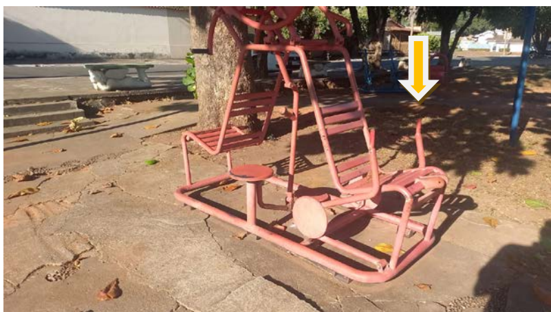
Aparelho com falta das borrachas de apoio e sustentação às mãos
