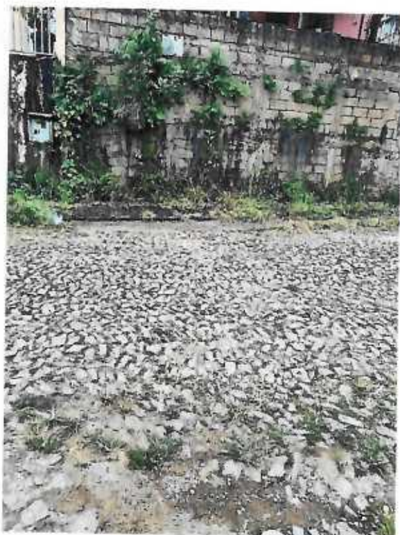
019-asfaltamento rua São João
