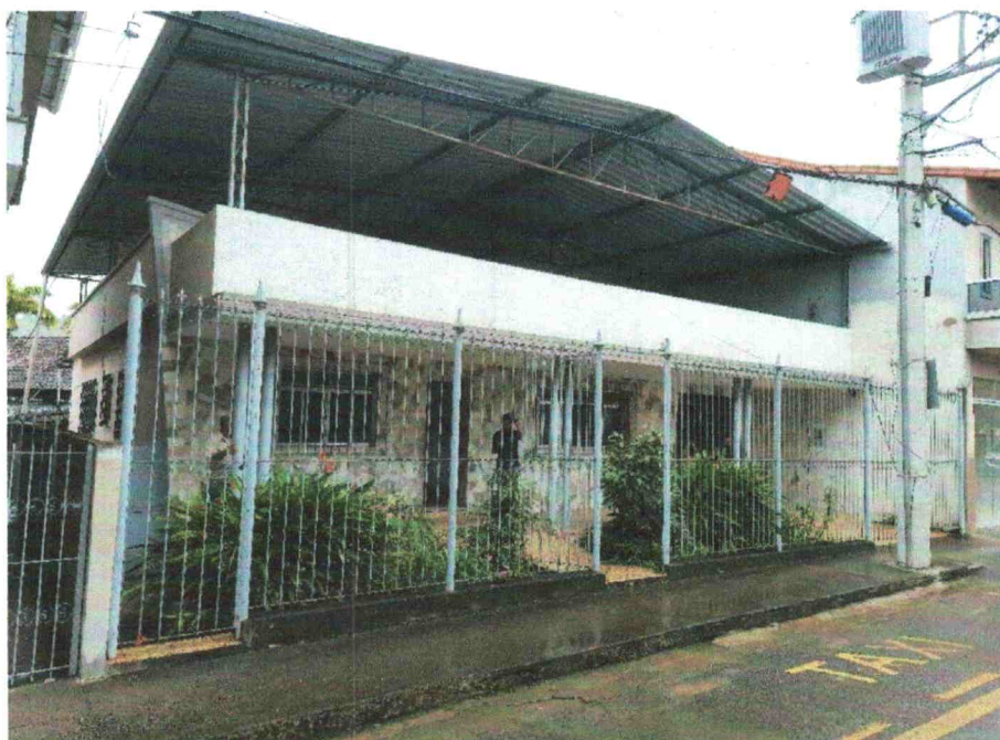
Figura 2 – Vista da fachada da casa. Revestimento em bom estado de conservação, necessitando de reparos na pintura.
