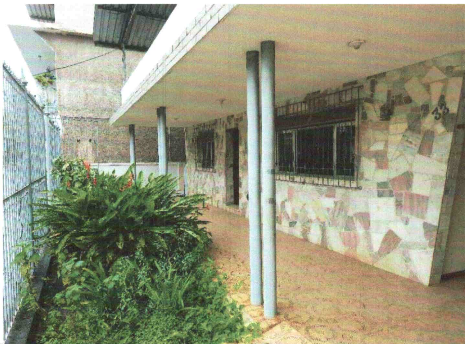
Figura 4 – Vista da fachada da casa. Revestimento em bom estado de conservação, necessitando de reparos na pintura.
