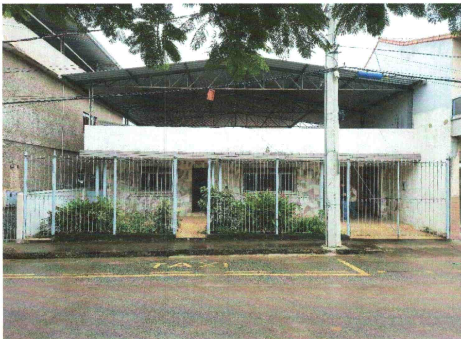
Figura 1 – Vista da fachada da casa. Revestimento em bom estado de conservação, necessitando de reparos na pintura.
