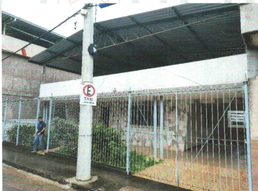
Figura 3 – Vista da fachada da casa. Revestimento em bom estado de conservação, necessitando de reparos na pintura.
