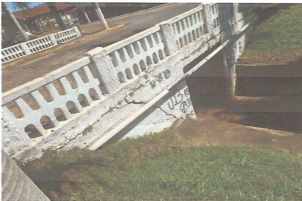
PONTE EXISTENTE NA RUA VITAL PAULINO DA COSTA NO CRUZAMENTO COM A RUA MARECHAL DEODORO.
