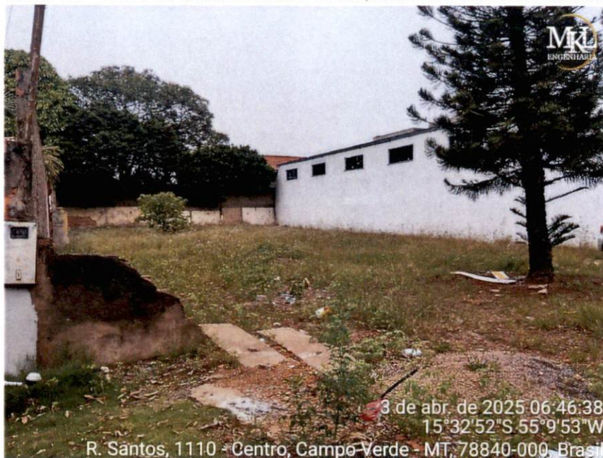
Anexo A4 – Muros nas laterais e no fundo do lote, limites com os imóveis vizinhos
