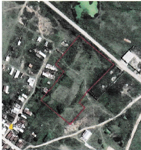
Figura 1: Imagem aérea do imóvel
