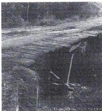
Figura 19: Vista lateral da ponte.
