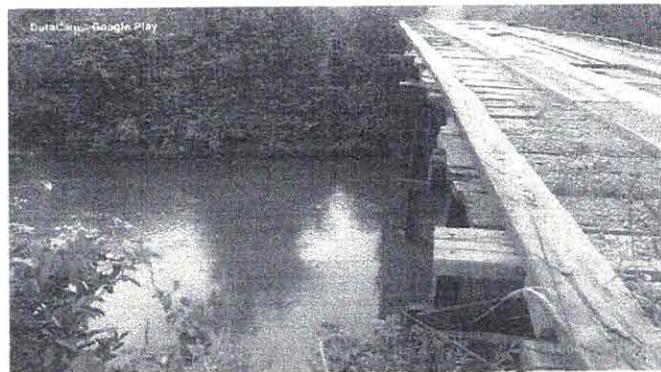
Figura 02: Vista lateral da ponte
