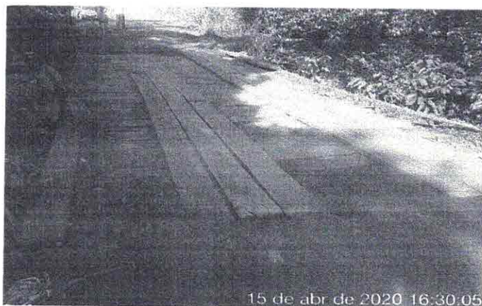
Figura 21: Vista superior da ponte
