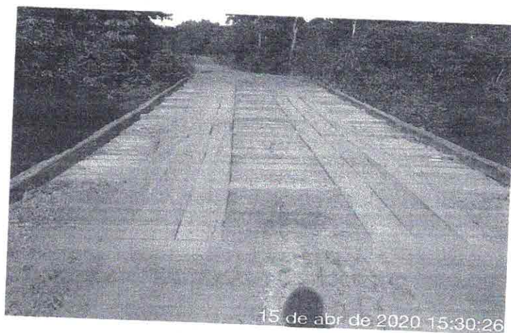
Figura 17: Vista superior da ponte.
