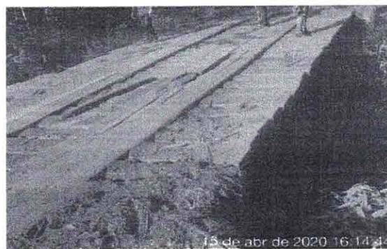
Figura 20: Vista lateral da ponte.
