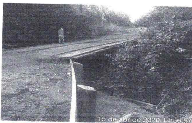
Figura 15: Vista lateral da ponte
