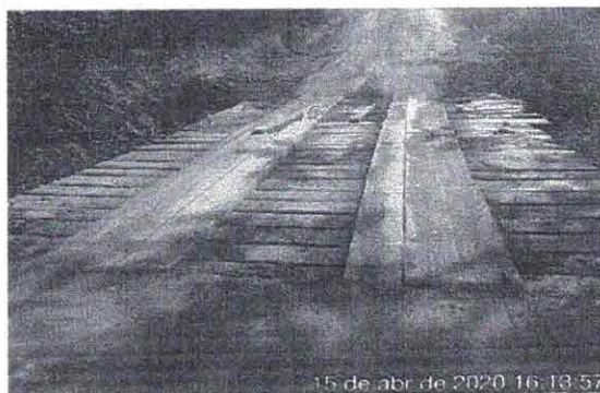
Figura 18: Vista superior da ponte.
