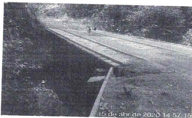
Figura 13: Vista lateral da ponte.
