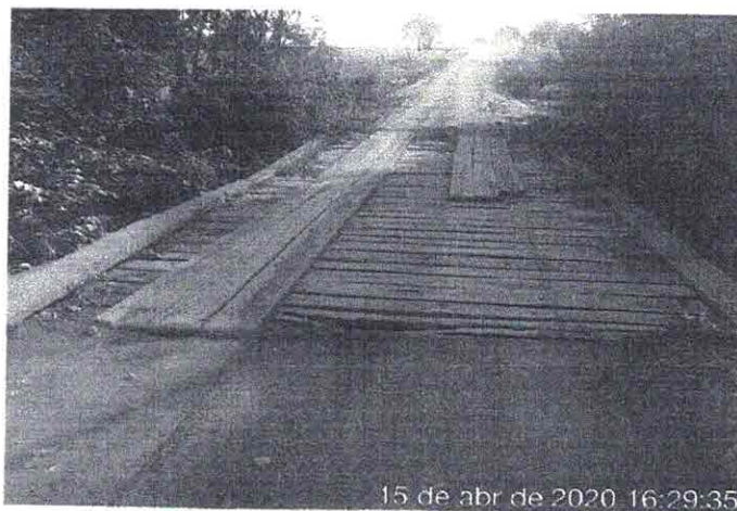
Figura 22: Vista superior da ponte
