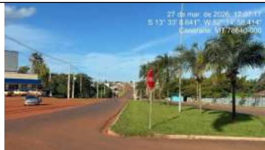
FOTO 02 - EXTENSÃO DA AVENIDA RIO GRANDE DO SUL - LADO DIREITO – Incluirá pavimentação asfáltica com sinalização vertical e horizontal e calçada com acessibilidade; sistema de iluminação pública e rede de abastecimento de água.
