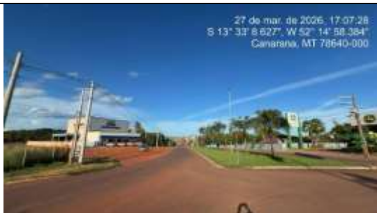
FOTO 01 - EXTENSÃO DA AVENIDA RIO GRANDE DO SUL - LADO DIREITO – Incluirá pavimentação asfáltica com sinalização vertical e horizontal e calçada com acessibilidade; sistema de iluminação pública e rede de abastecimento de água.
