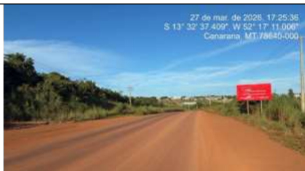
FOTO 11 - AVENIDA SETE DE SETEMBRO - LADO ESQUERDO - Intervenção incluirá pavimentação e rede de abastecimento de água e sistema de iluminação pública.
