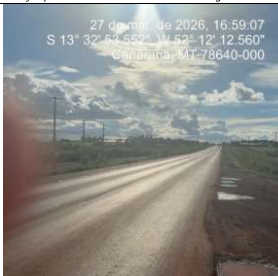
FOTO 03 - EXTENSÃO DA AVENIDA RIO GRANDE DO SUL - LADO DIREITO – Incluirá pavimentação asfáltica com sinalização vertical e horizontal e calçada com acessibilidade; sistema de iluminação pública e rede de abastecimento de água.
