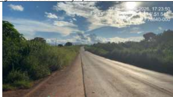
FOTO 16 - AVENIDA SETE DE SETEMBRO - LADO ESQUERDO - Intervenção incluirá pavimentação e rede de abastecimento de água e sistema de iluminação pública.
