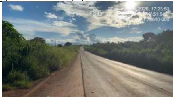
FOTO 15 - AVENIDA SETE DE SETEMBRO - LADO ESQUERDO - Intervenção incluirá pavimentação e rede de abastecimento de água e sistema de iluminação pública.
