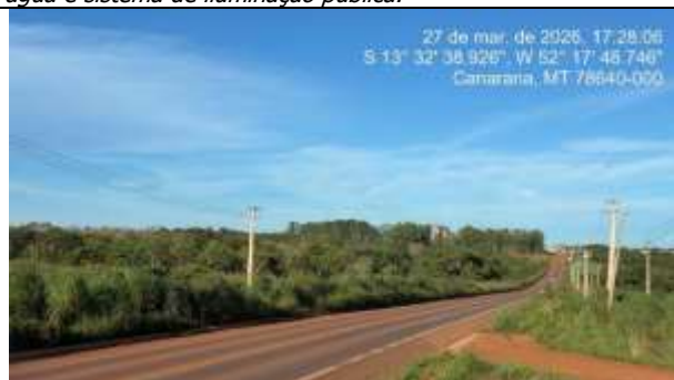
FOTO 14 - AVENIDA SETE DE SETEMBRO - LADO ESQUERDO - Intervenção incluirá pavimentação e rede de abastecimento de água e sistema de iluminação pública.
