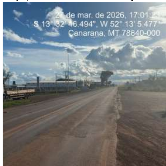
FOTO 04 - EXTENSÃO DA AVENIDA RIO GRANDE DO SUL - LADO DIREITO – Incluirá pavimentação asfáltica com sinalização vertical e horizontal e calçada com acessibilidade; sistema de iluminação pública e rede de abastecimento de água.
