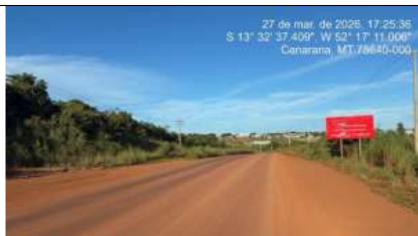
FOTO 12 - AVENIDA SETE DE SETEMBRO - LADO ESQUERDO - Intervenção incluirá pavimentação e rede de abastecimento de água e sistema de iluminação pública.
